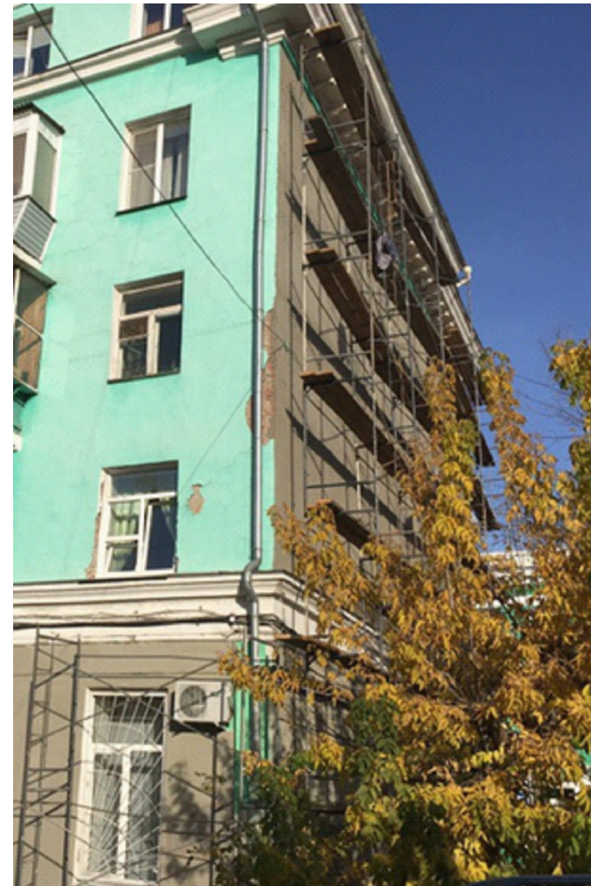
Боковой фасад с южной стороны
