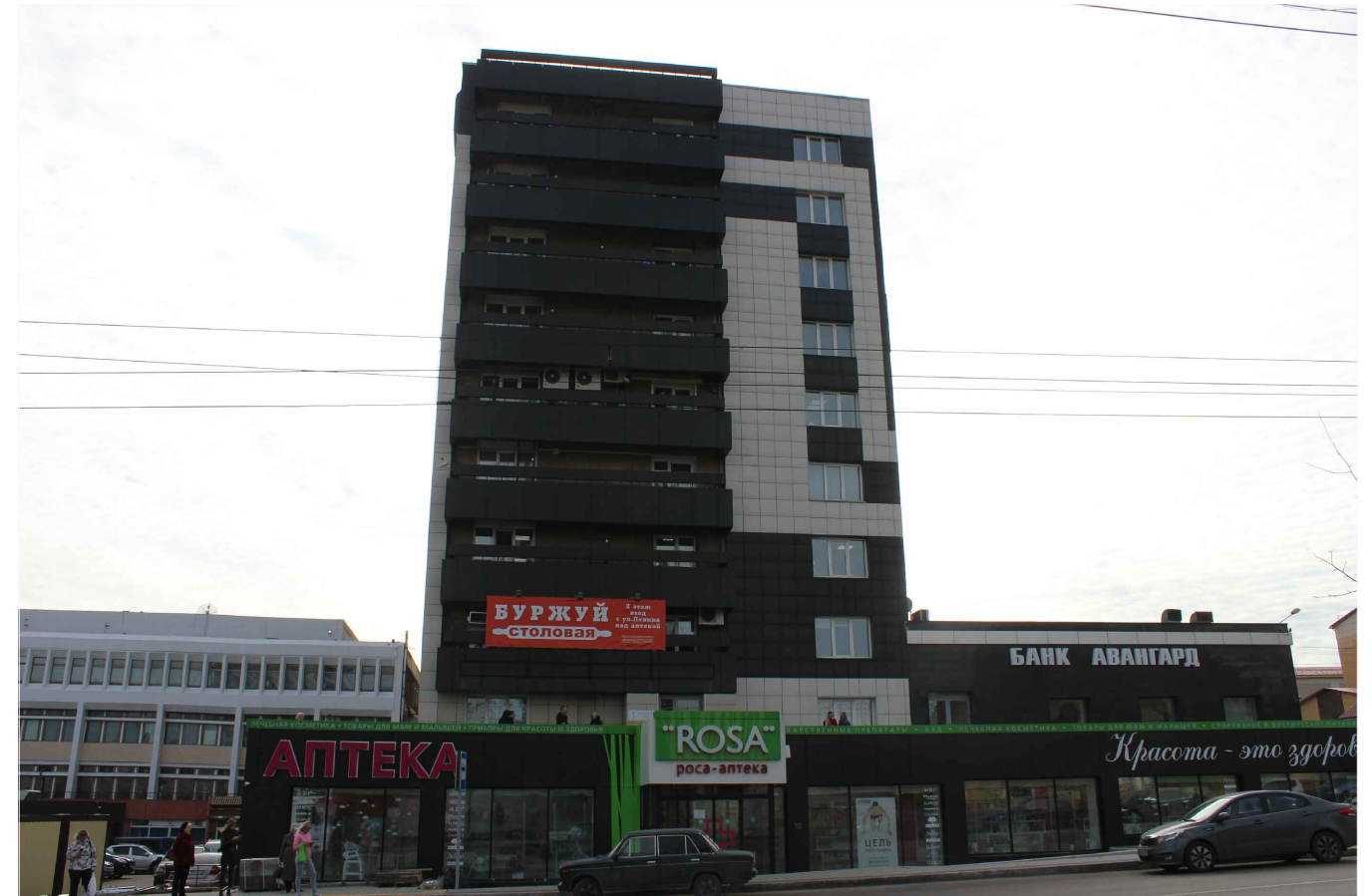
Боковой фасад (северный фасад в осях А-Е)
