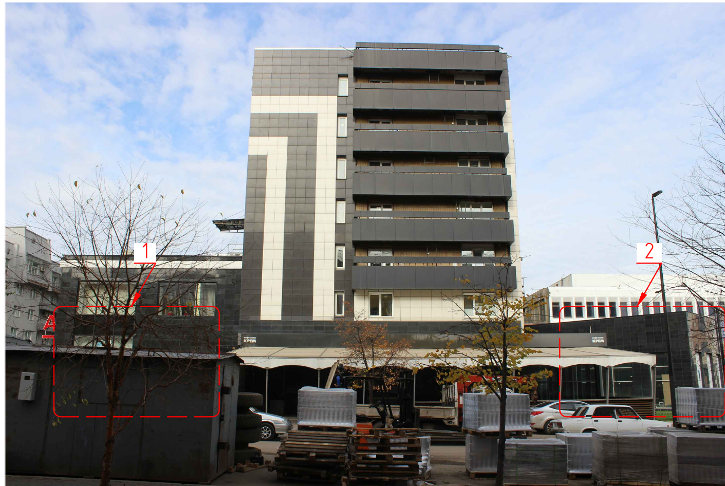
Боковой фасад (южный фасад в осях Е-А)
