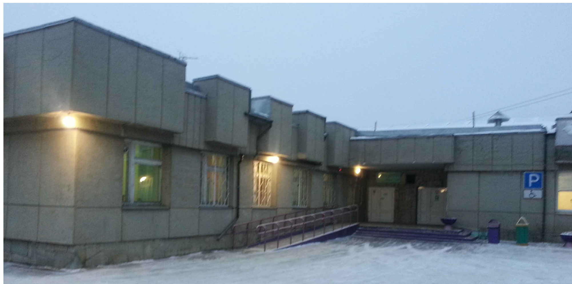
Материалы фотофиксации существующего состояния фасадов. Фрагмент бокового фасада по оси 4 в осях А-Б.
