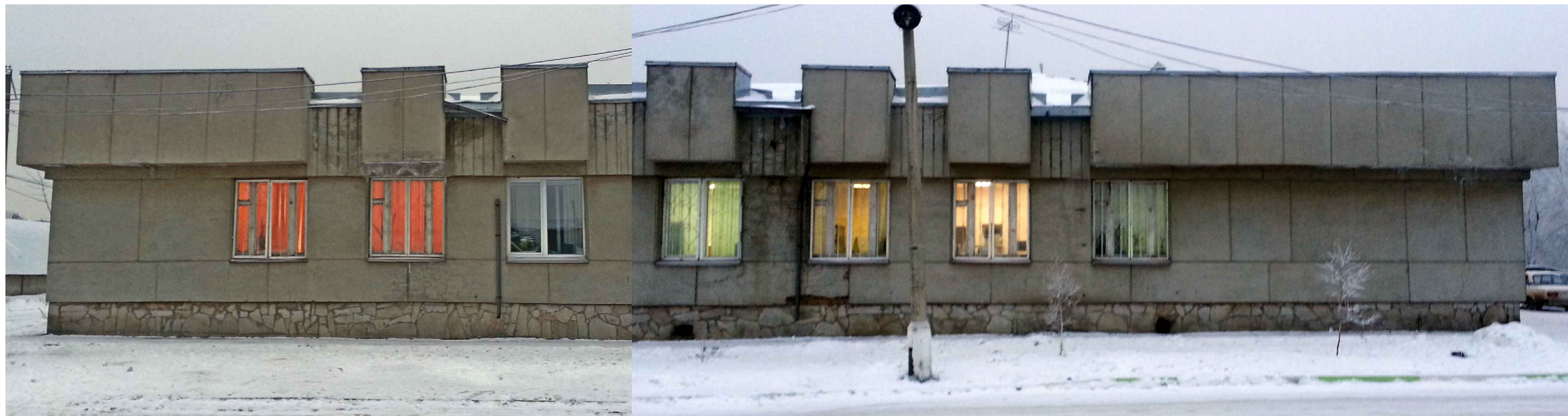
Материалы фотофиксации существующего состояния фасадов. Фасад по оси 1 в осях Ж-А.
