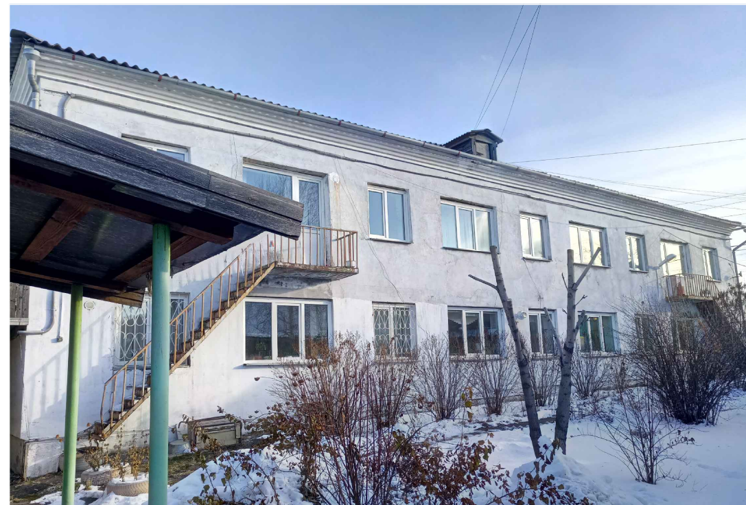
Дворовой фасад (западный фасад в осях Г-А)
