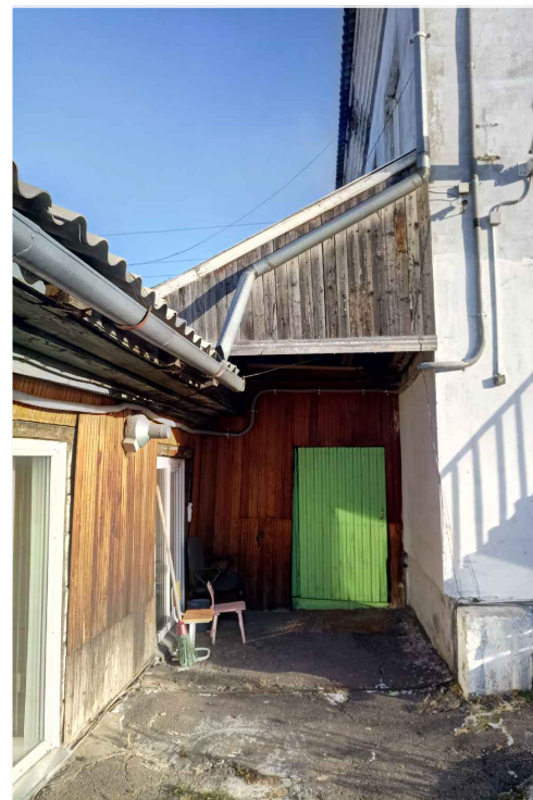
Дворовой фасад (западный фасад в осях В-Б)
