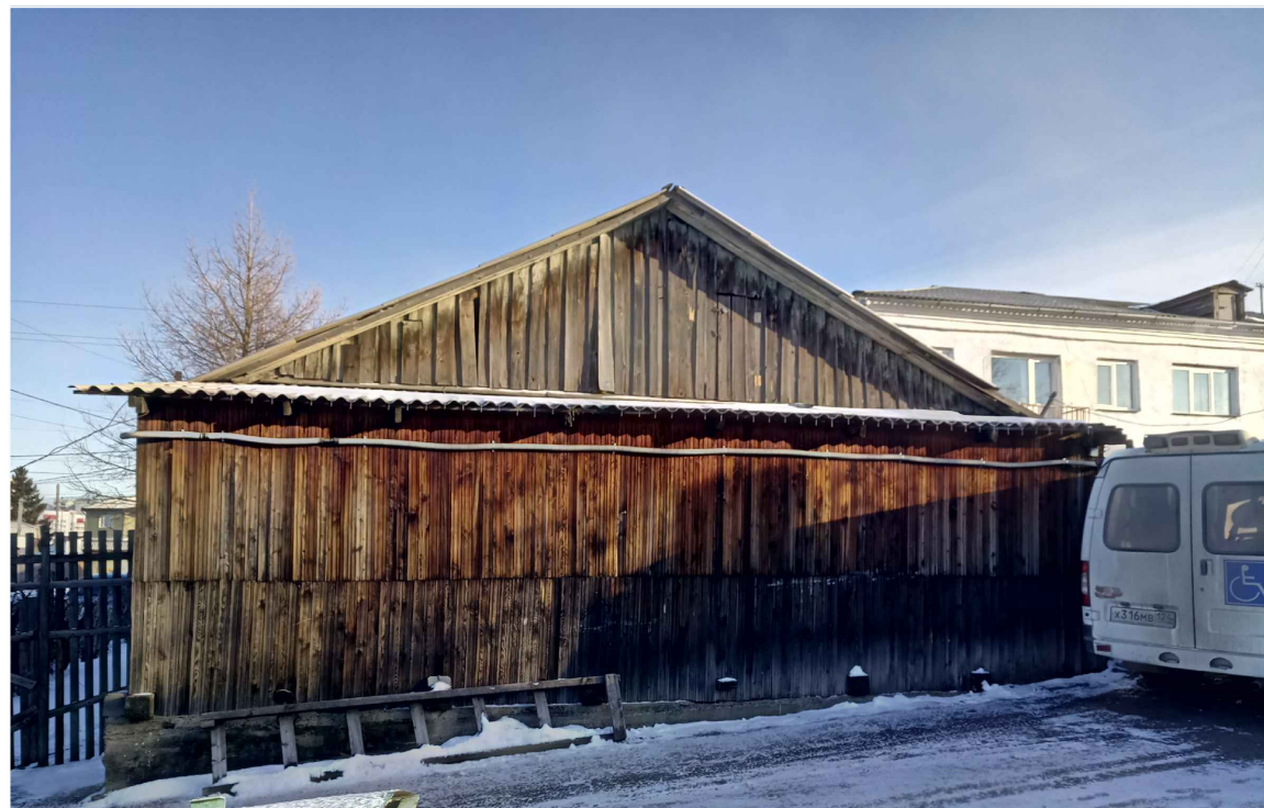
Дворовой фасад (западный фасад в осях Д-Г)
