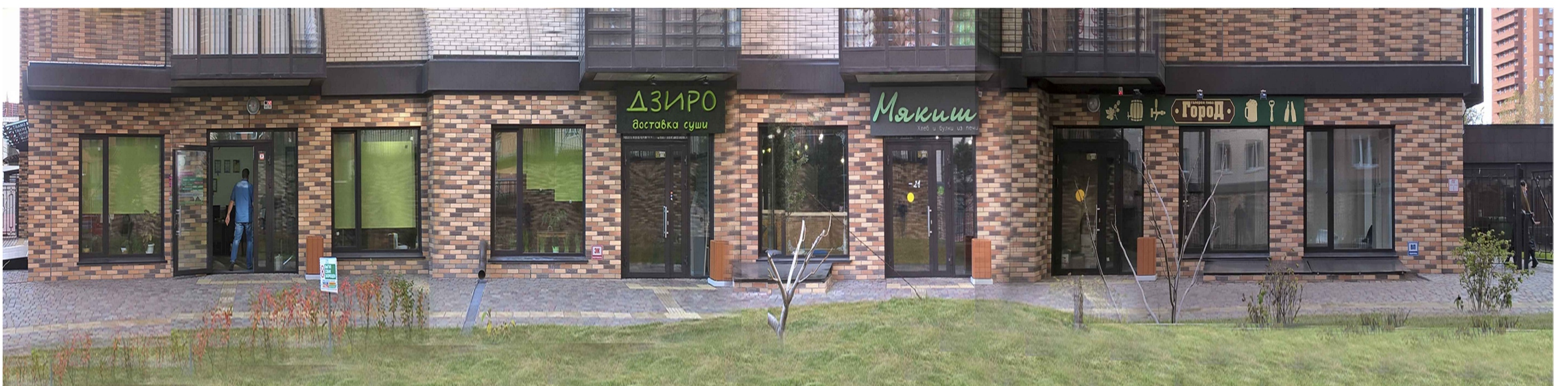
ДВОРОВОЙ ФАСАД (ВОСТОЧНЫЙ)
