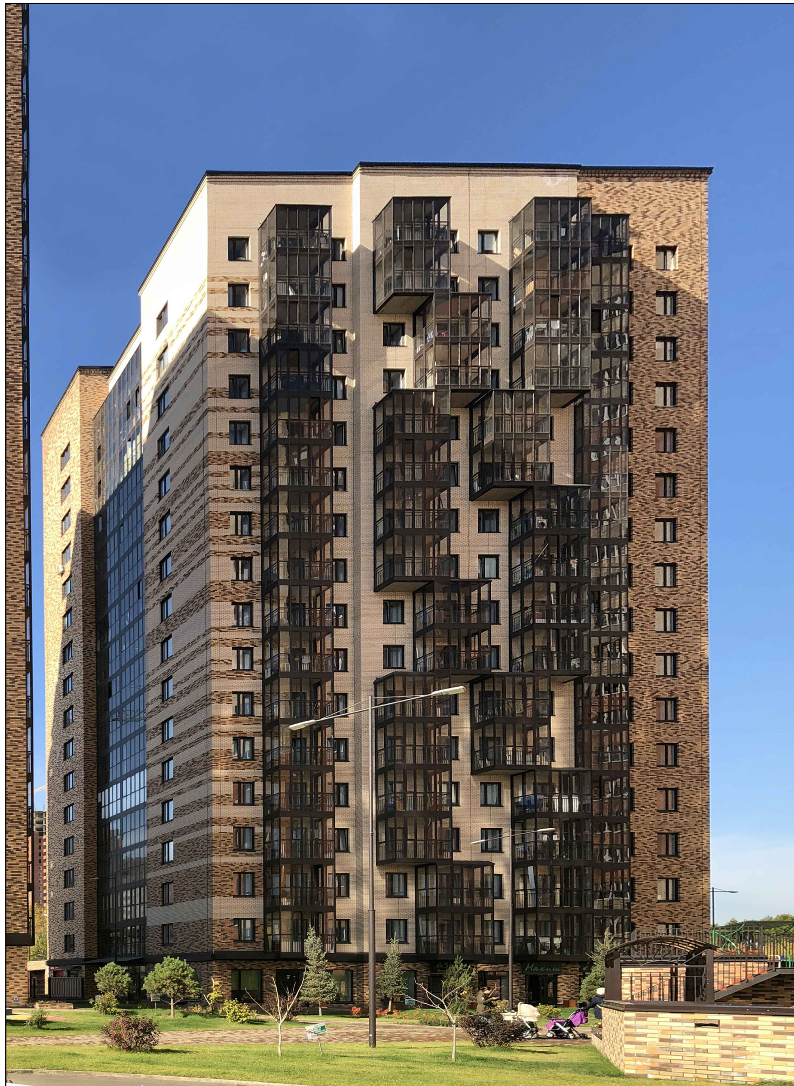
ДВОРОВОЙ ФАСАД - ВОСТОЧНЫЙ (со стороны ул. Шахтеров)
