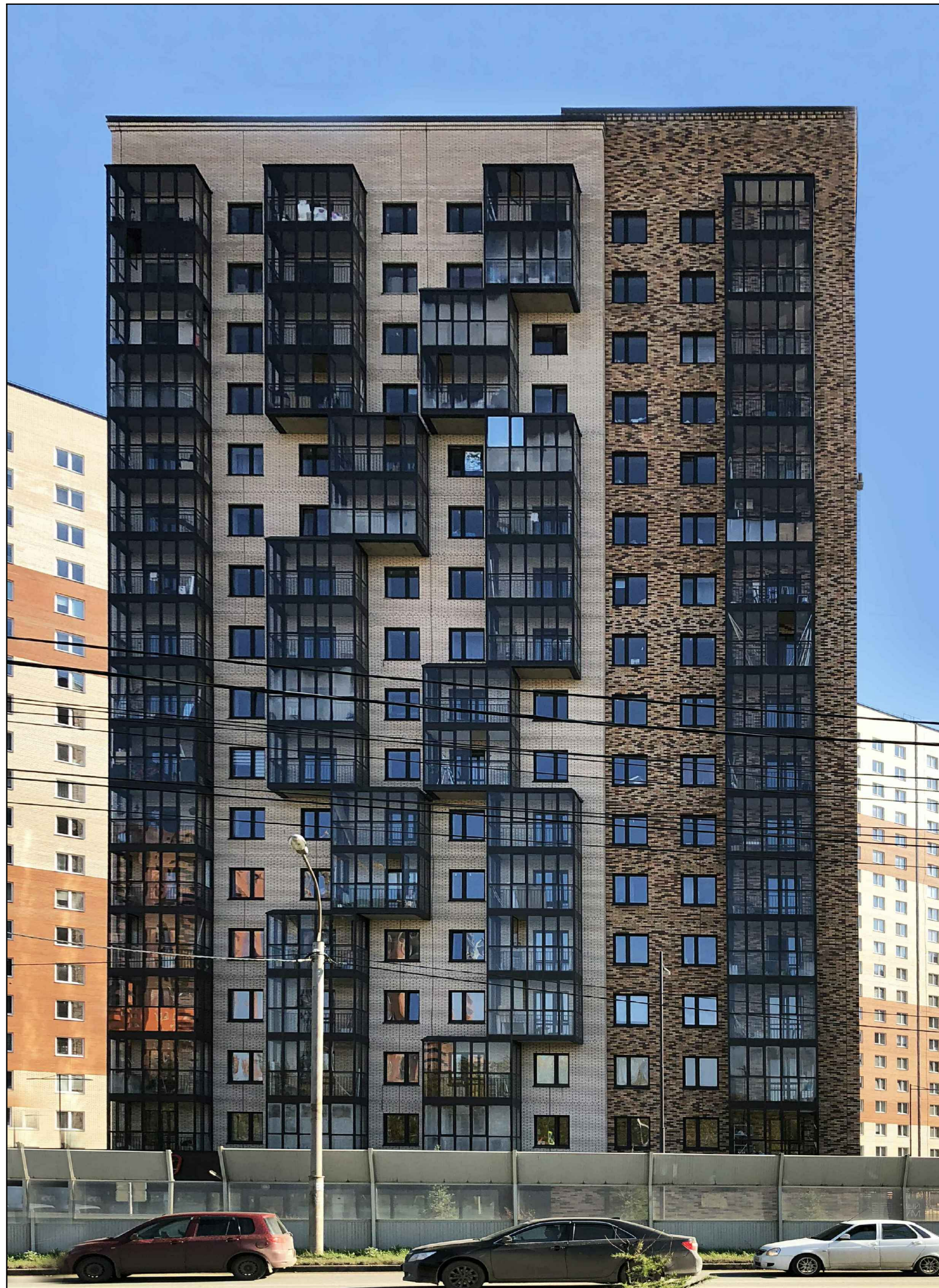
ГЛАВНЫЙ ФАСАД - ЗАПАДНЫЙ (со стороны ул. Линейная)
