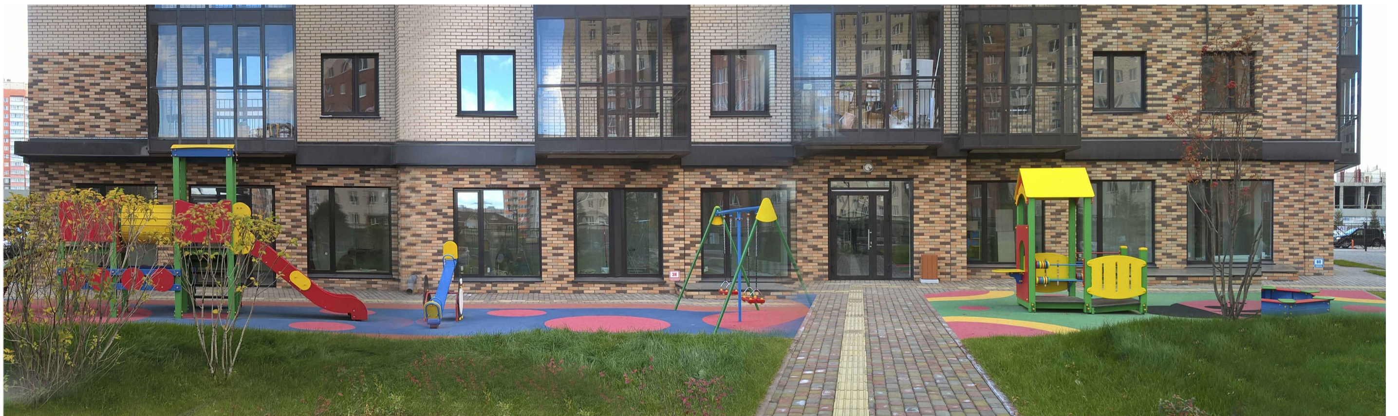
ДВОРОВОЙ ФАСАД (ВОСТОЧНЫЙ)
