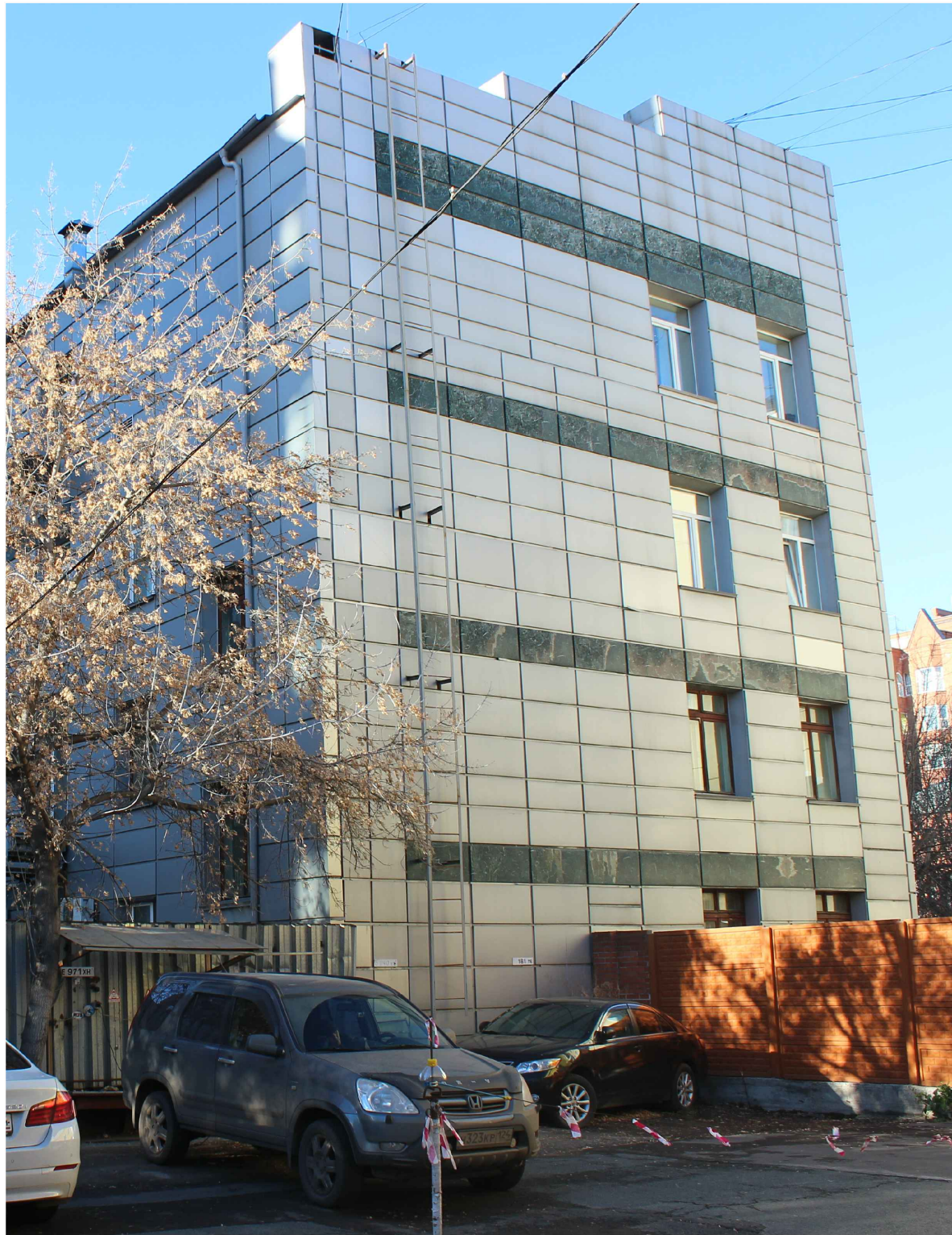
Боковой фасад (восточный фасад в осях А-Б)
