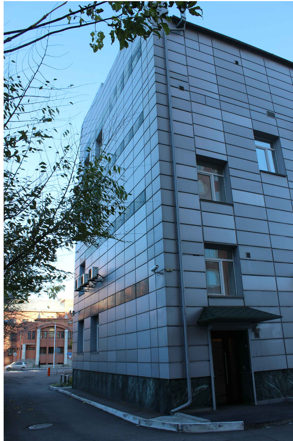
Боковой фасад (западный фасад в осях Б-А)
