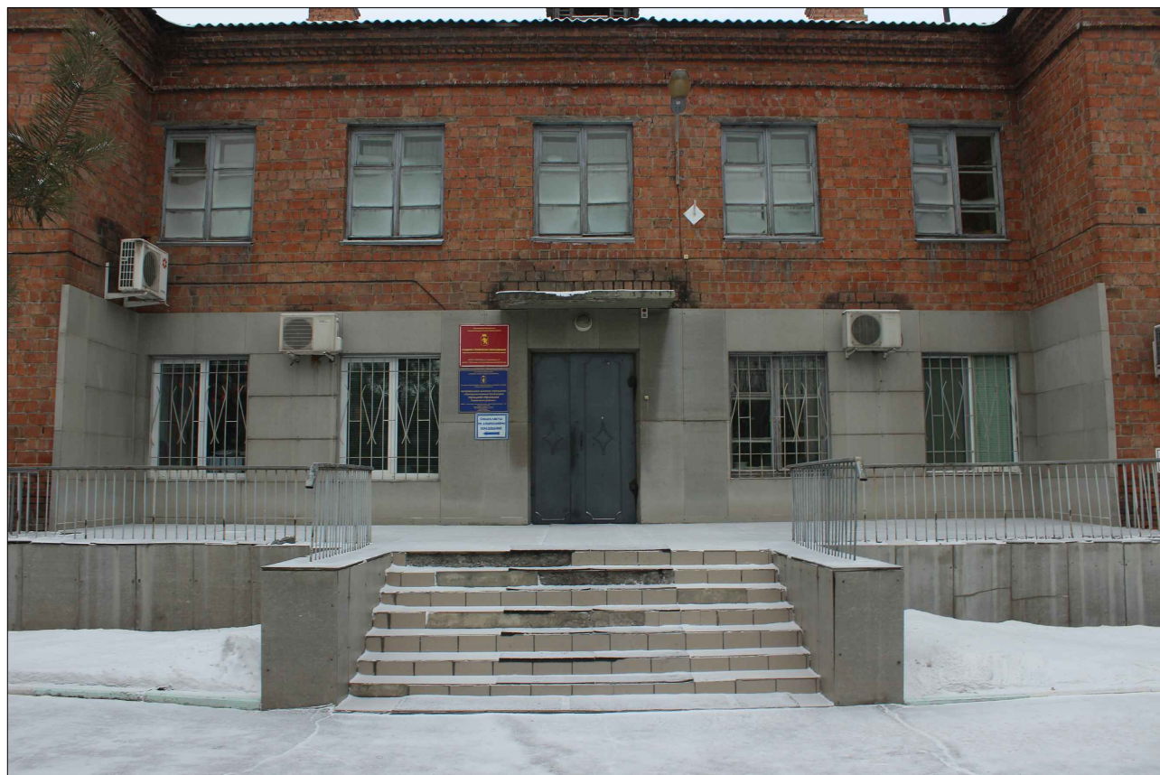
Вид Б. Фрагмент главного фасада
