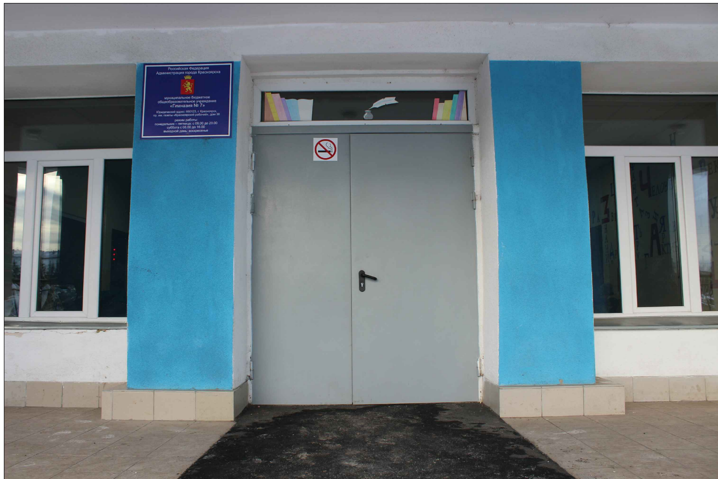
Вид Б. Фрагмент главного фасада
