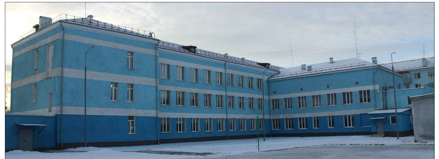
Вид Д. Фрагмент дворового фасада
