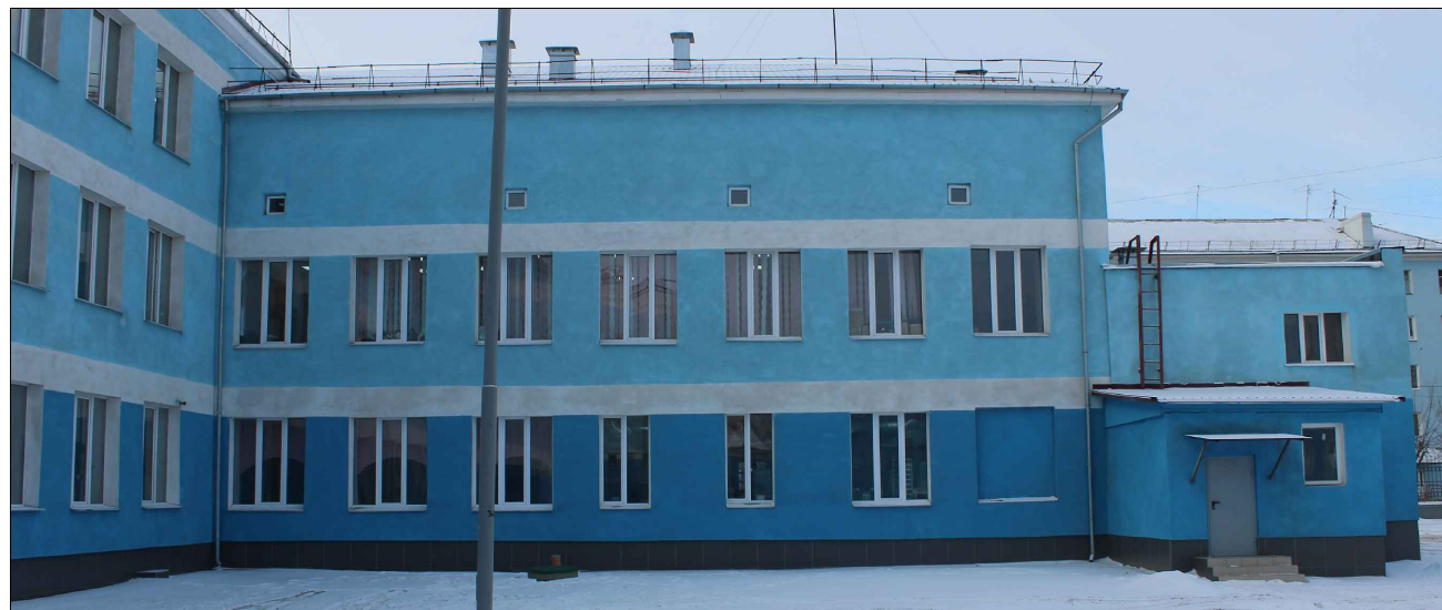
Вид Г. Фрагмент дворового фасада
