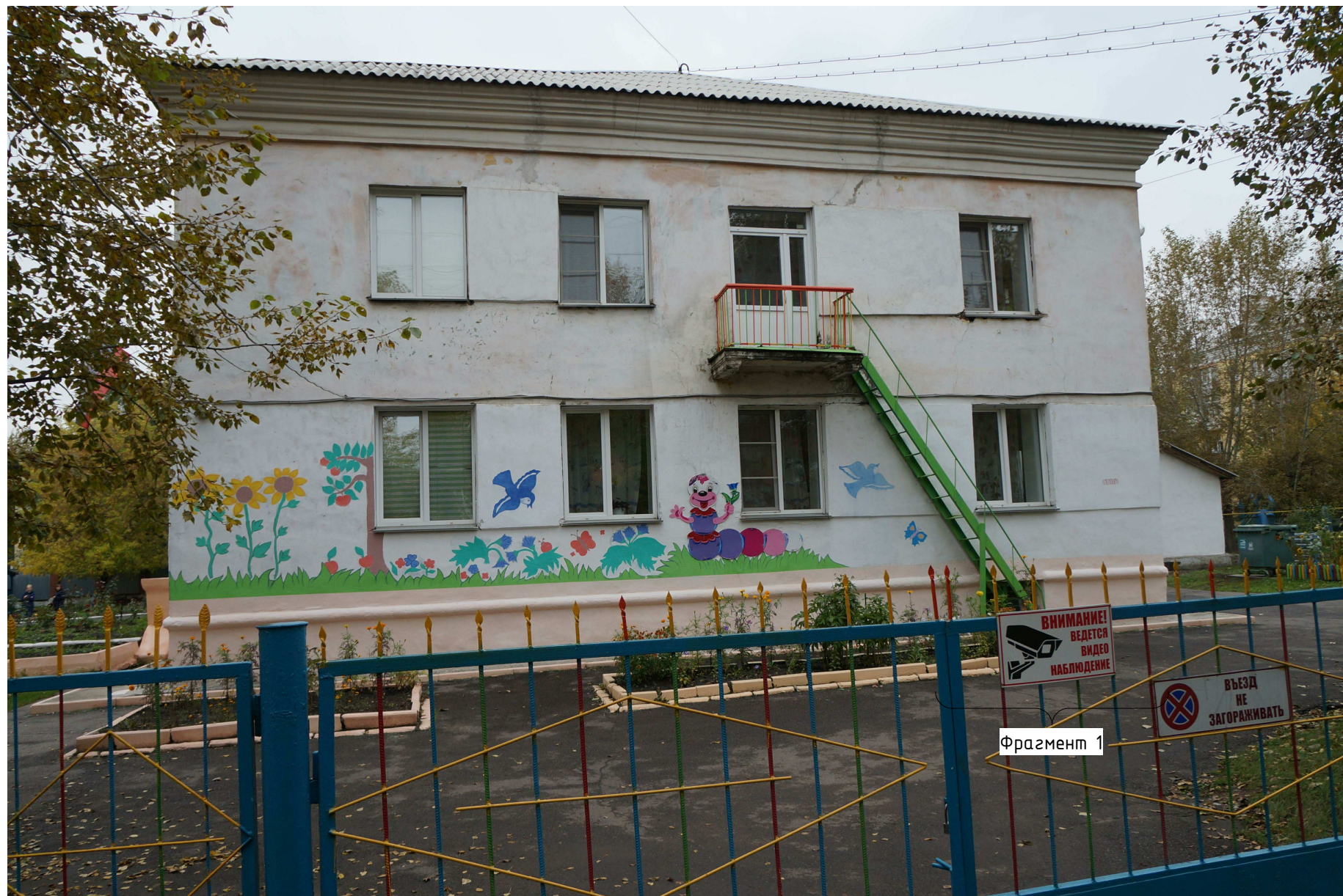
Фотофиксация бокового (северо-восточного) фасада
