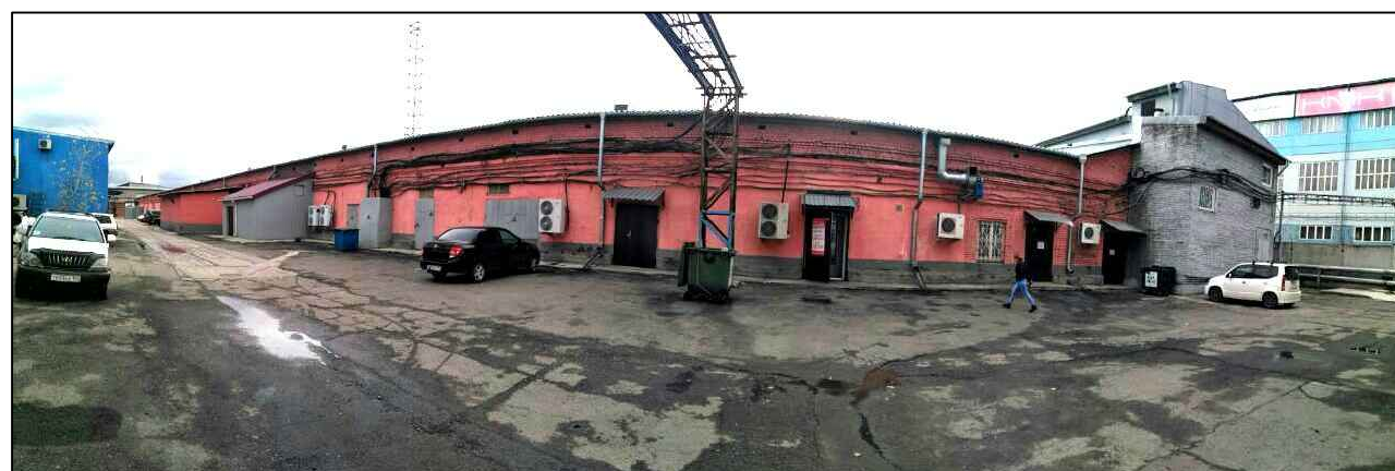
рис. 10 Фрагмент северного фасада (западная часть)
