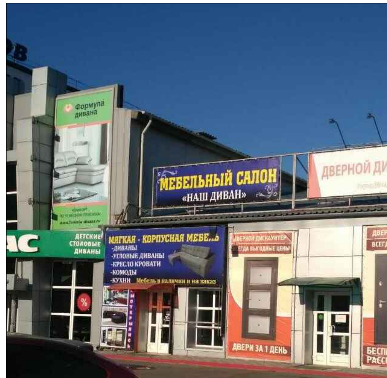
рис. 5 Вид на юго-восточный угол здания
