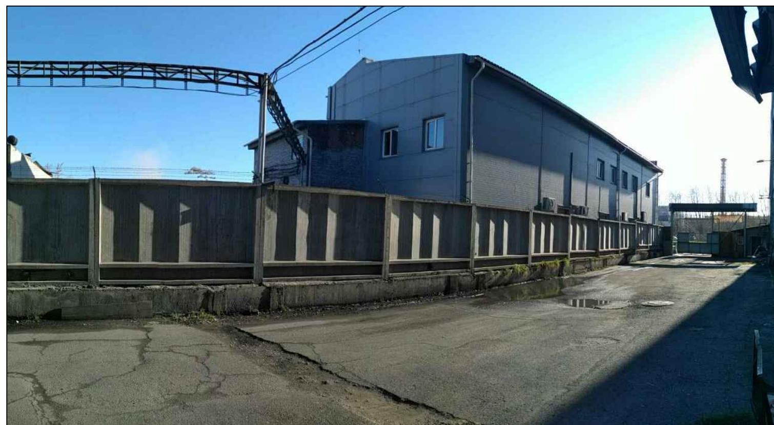
рис. 4 Вид на северо-западный угол здания
