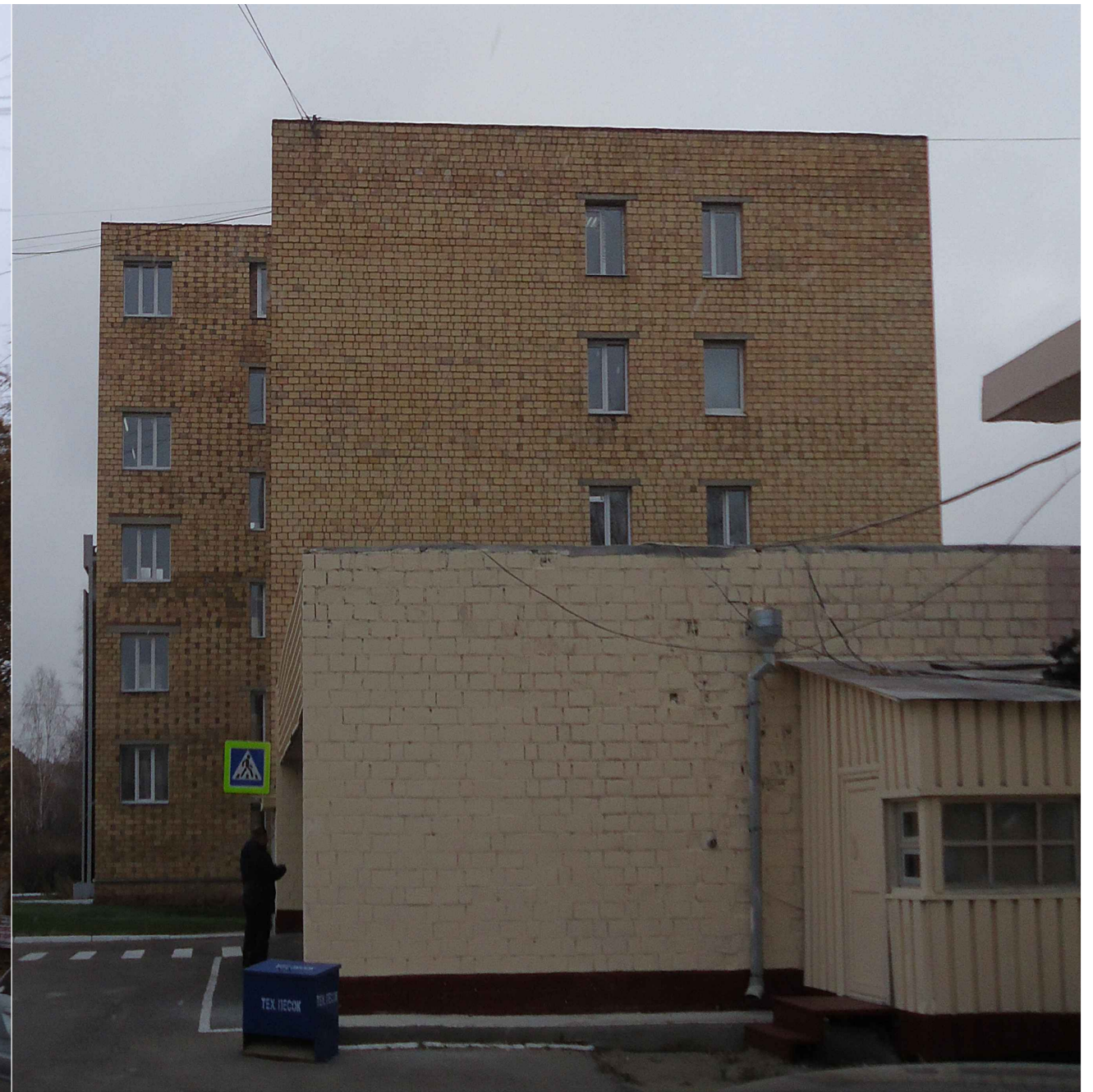
Боковой фасад со стороны главного входа в здание
