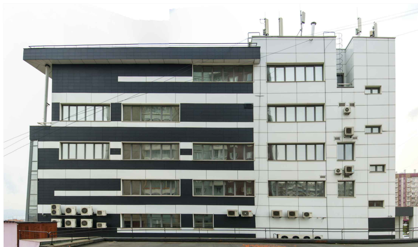
ФОТОФИКСАЦИЯ ДВОРОВОГО ФАСАДА
