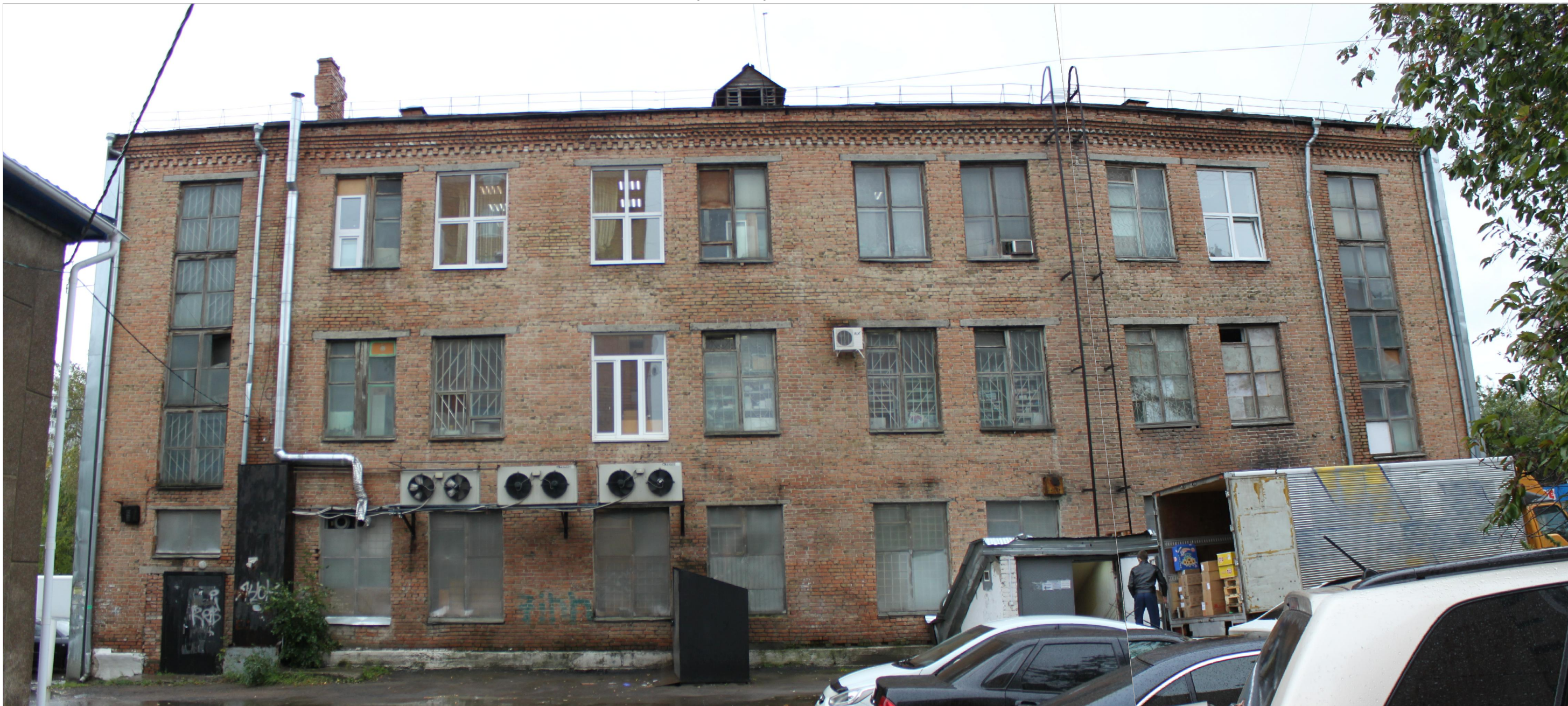
Материалы фотофиксации существующего состояния фасадов. Дворовой фасад в осях 2-1
