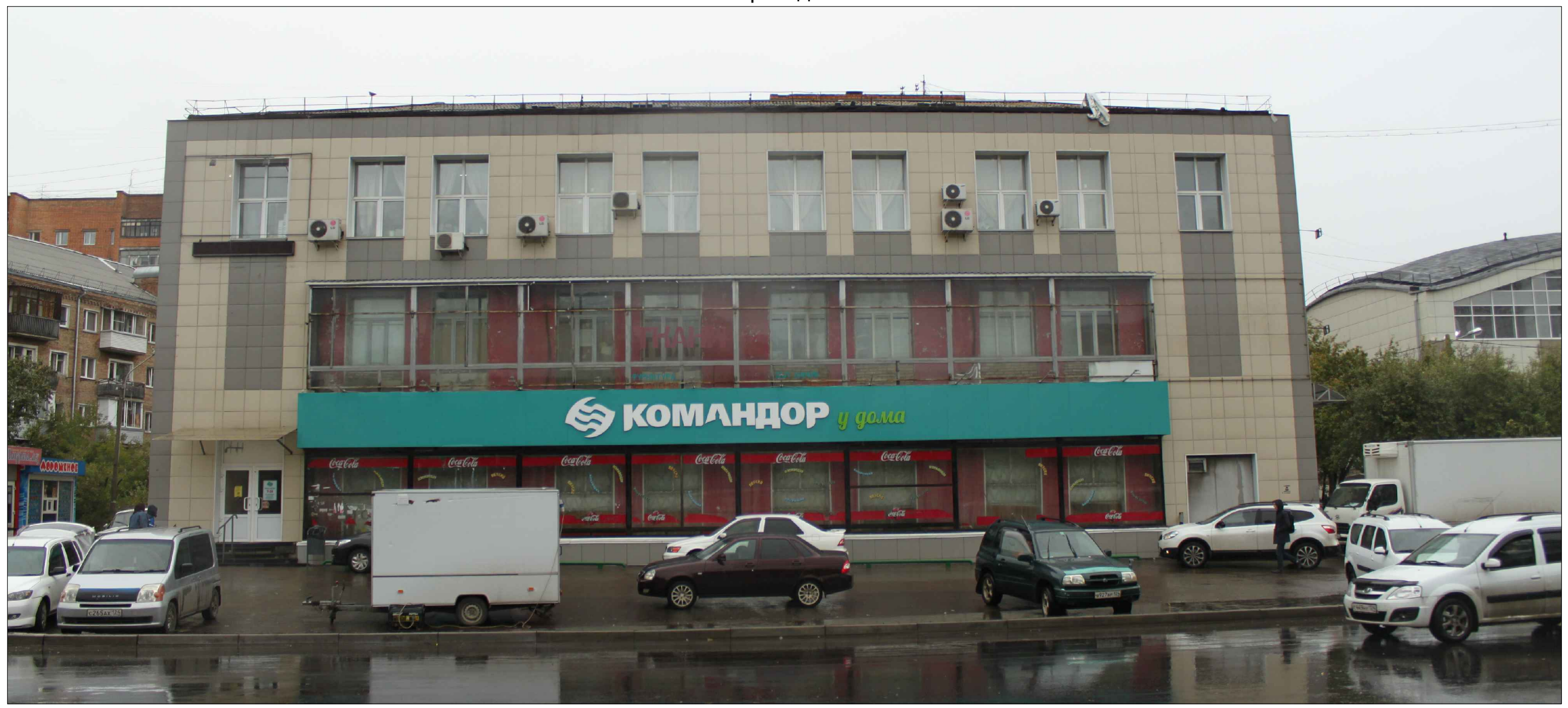
Материалы фотофиксации существующего состояния фасадов. Главный фасад в осях 1-2
