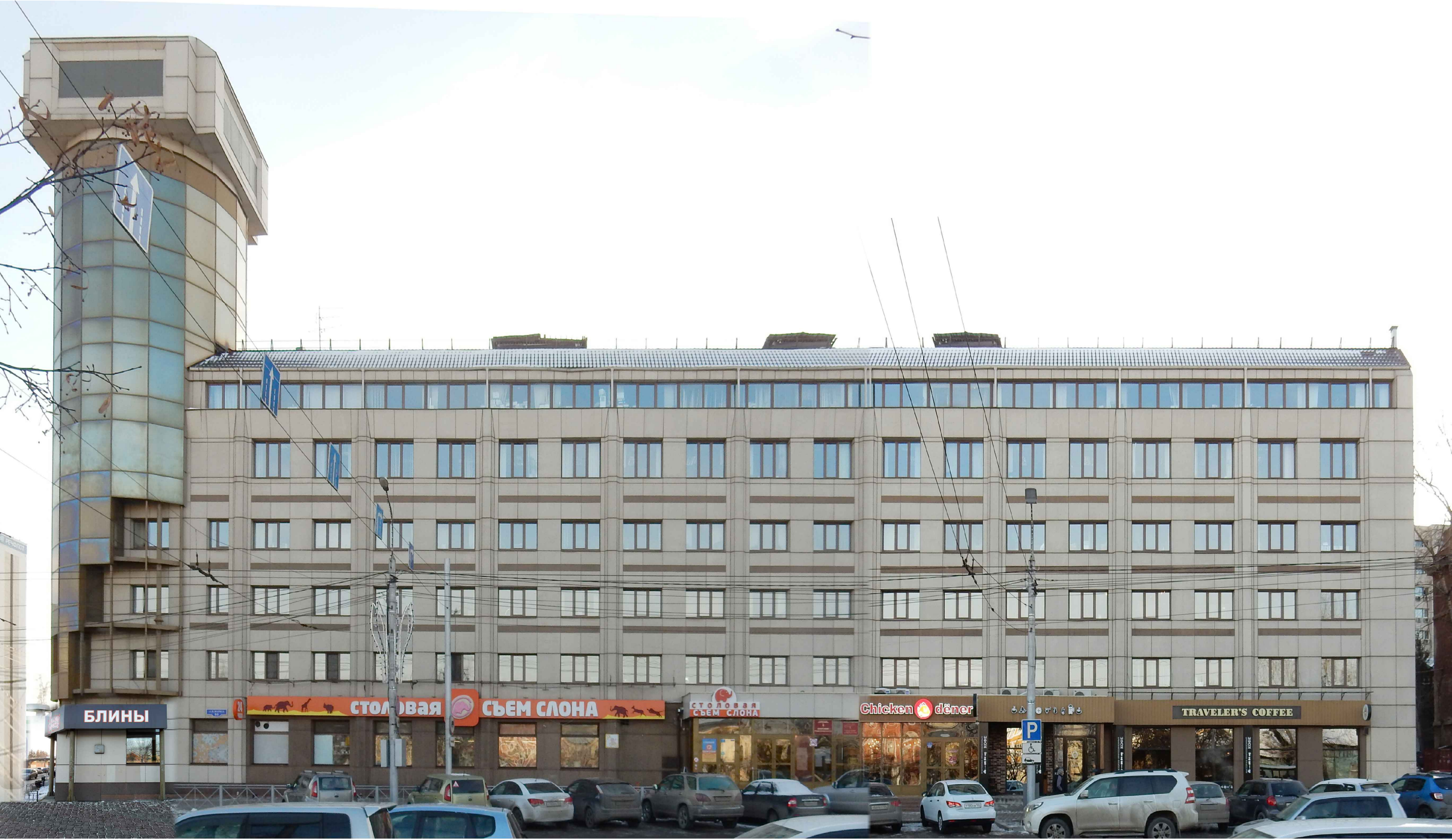
Главный фасад в осях 10-1
