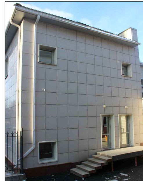
Фрагмент дворового фасада
