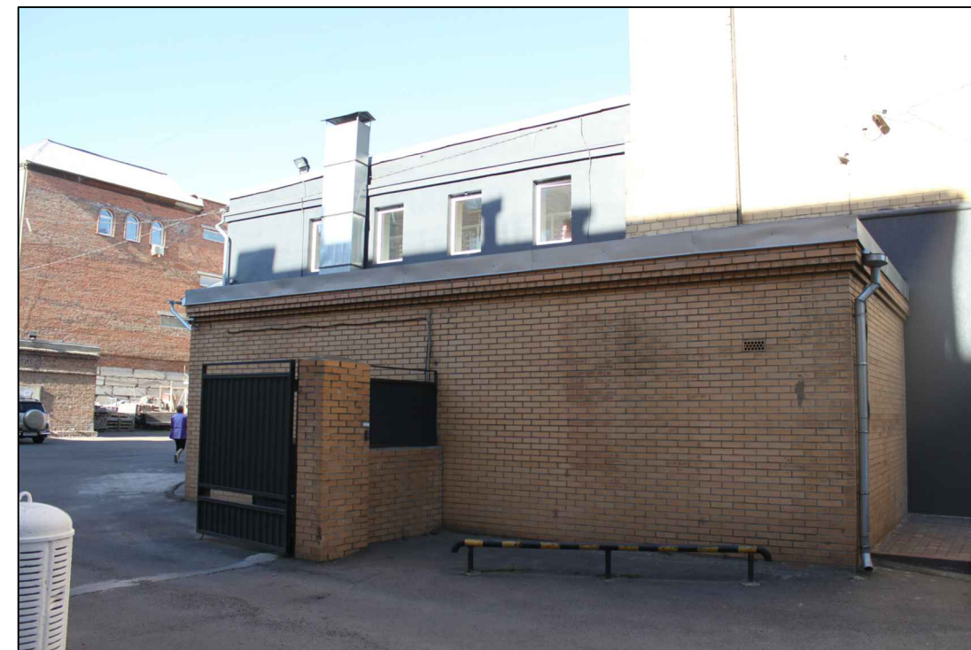
Фрагмент бокового фасада (со стороны внутреннего двора)
