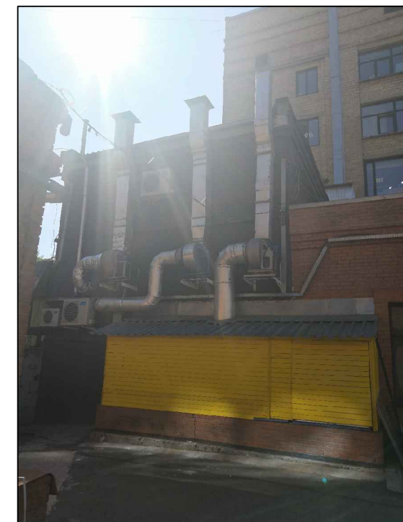
Фрагмент дворового фасада
