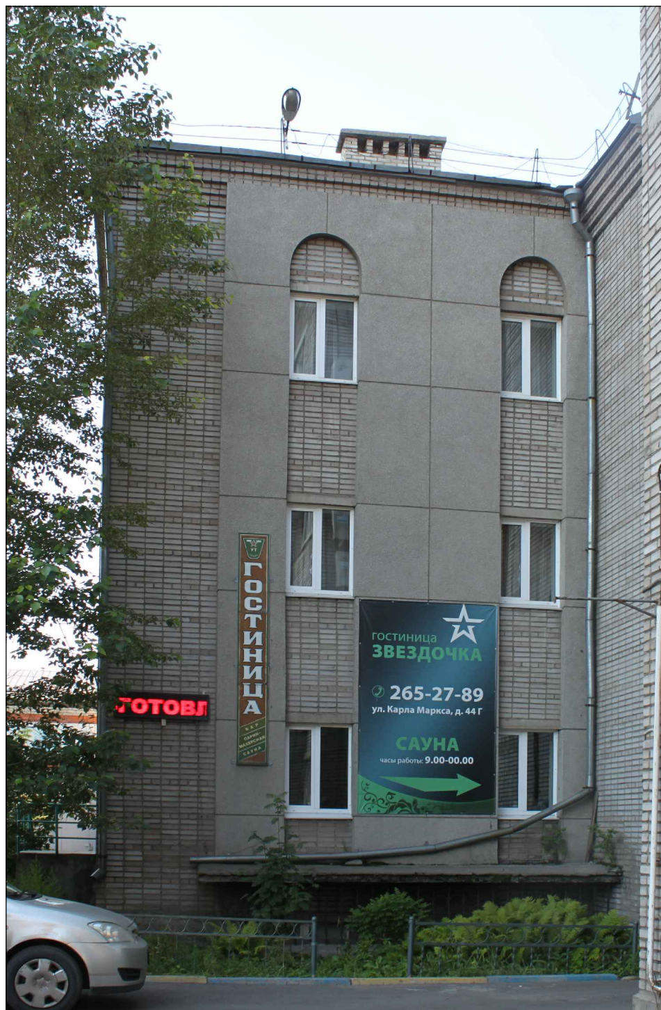
Фрагмент главного фасада в осях 1-2
