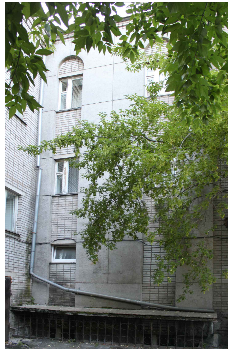
Фрагмент главного фасада в осях 3-4
