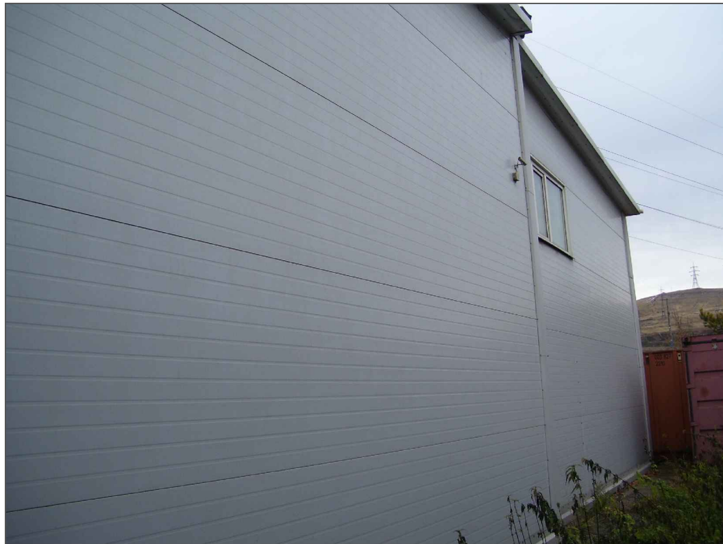
Фрагмент бокового (дворового) фасада в осях А-Е
