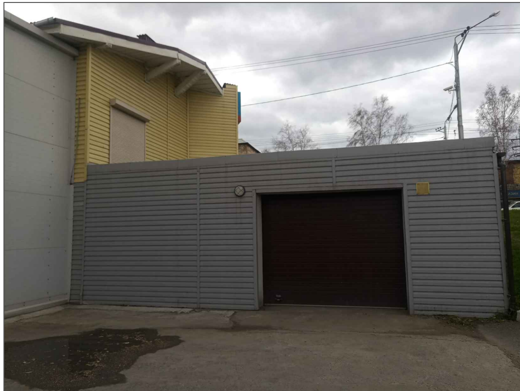
Фрагмент дворового фасада в осях 7-1
