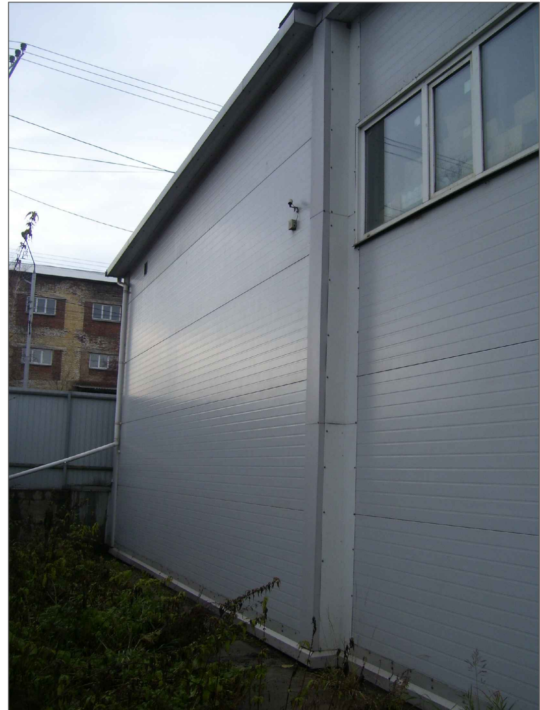
Фрагмент бокового (дворового) фасада в осях А-Е
