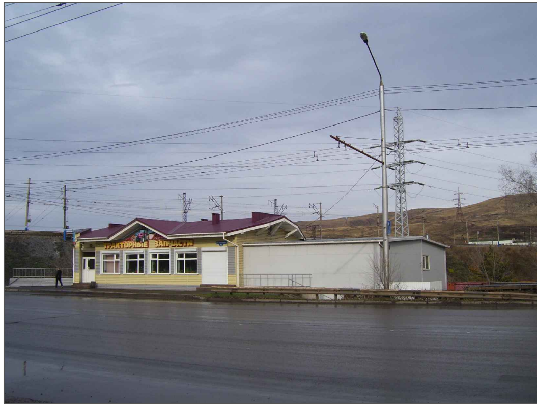
Фрагмент бокового (дворового) фасада в осях А-Е. Вид со стороны ул. Калинина
