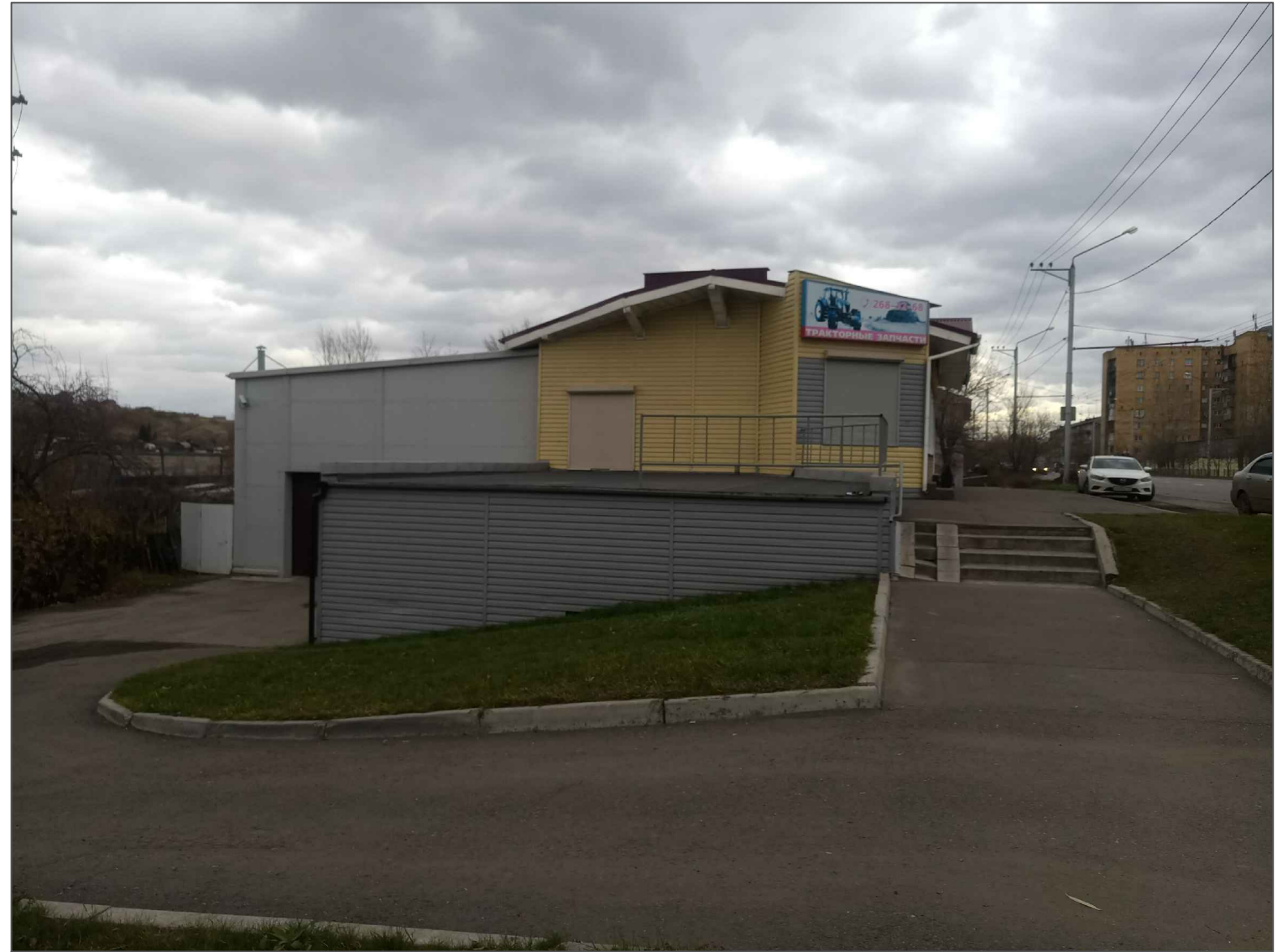
Боковой фасад. Вид со стороны ж / д виадука
