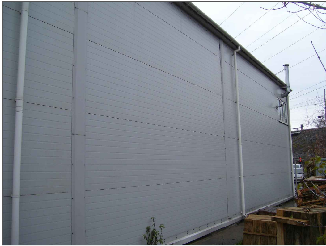
Фрагмент дворового фасада в осях 7-1
