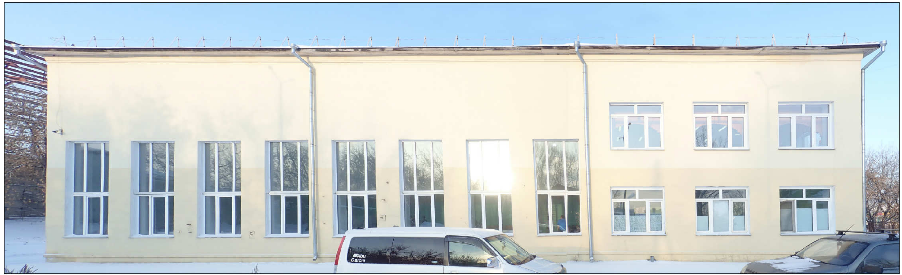
Фасад в осях Ж-Б
