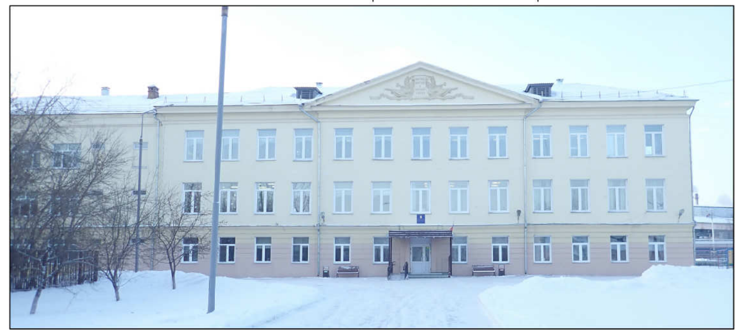
Фасад в осях 1-7. Фрагмент главного фасада.
