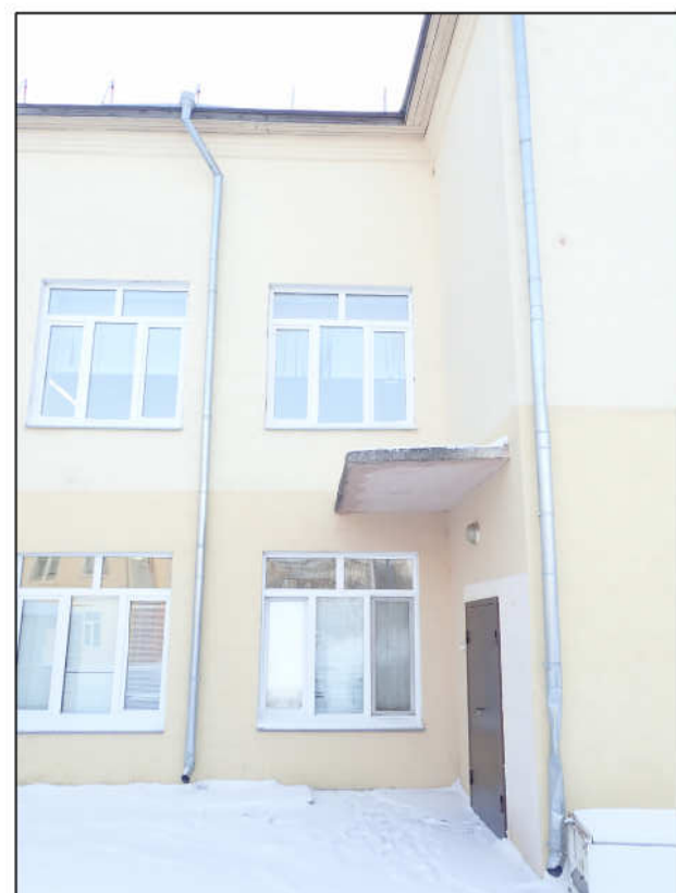
Фрагмент фасада в осях В-Ж
