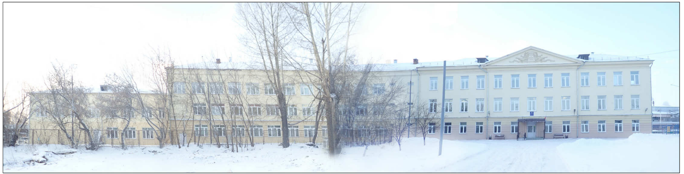
Фасад в осях 1-7. Фрагмент главного фасада.
