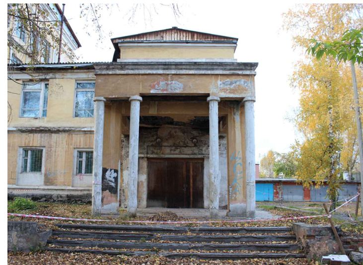
Фрагмент крыльца в осях 7-8
