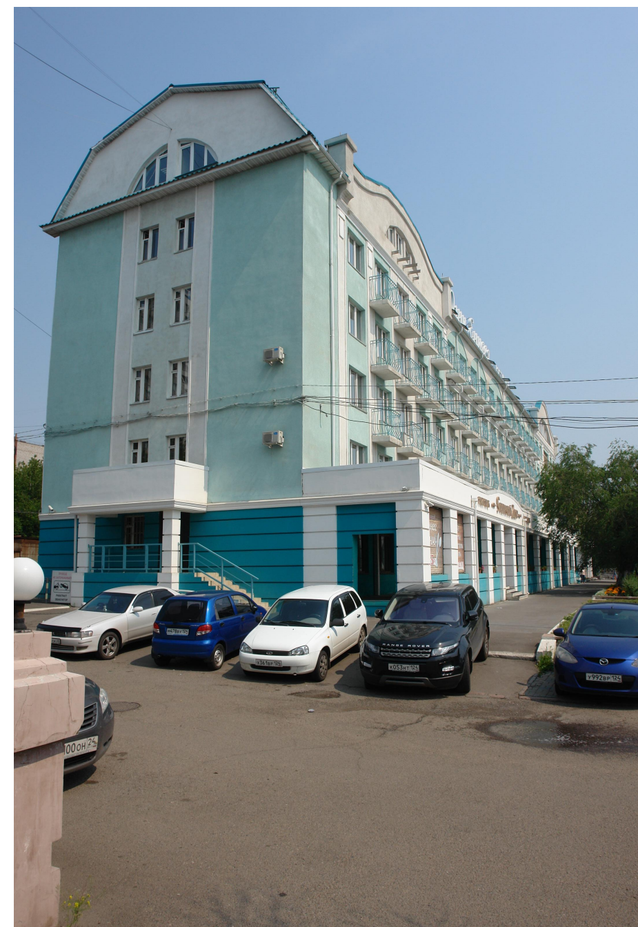
Боковой фасад (западный)
