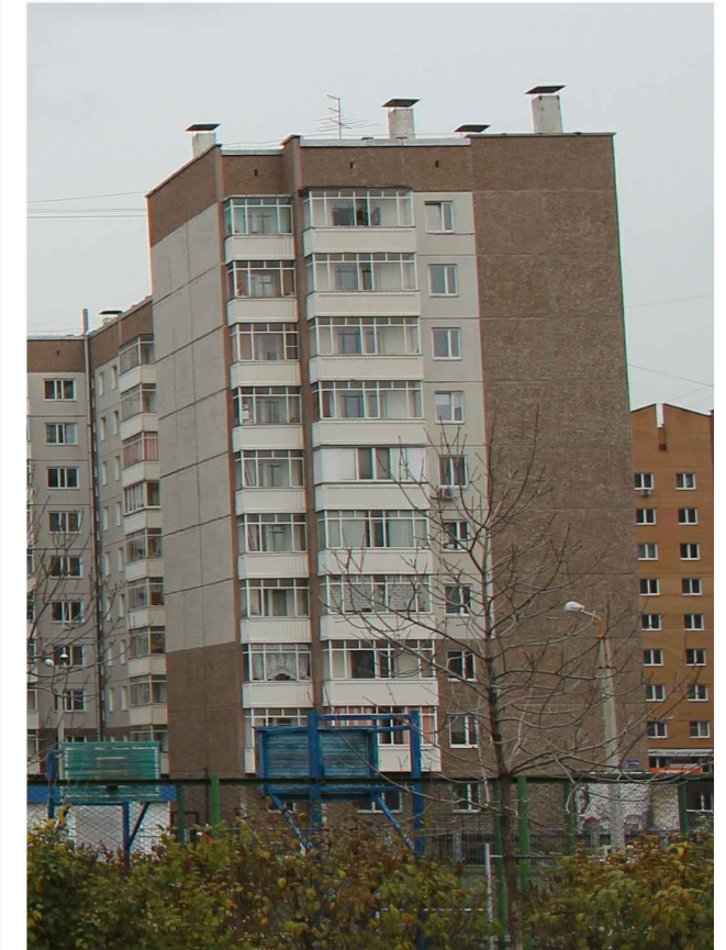
Боковой фасад (юго-западный фасад в осях 5-7)
