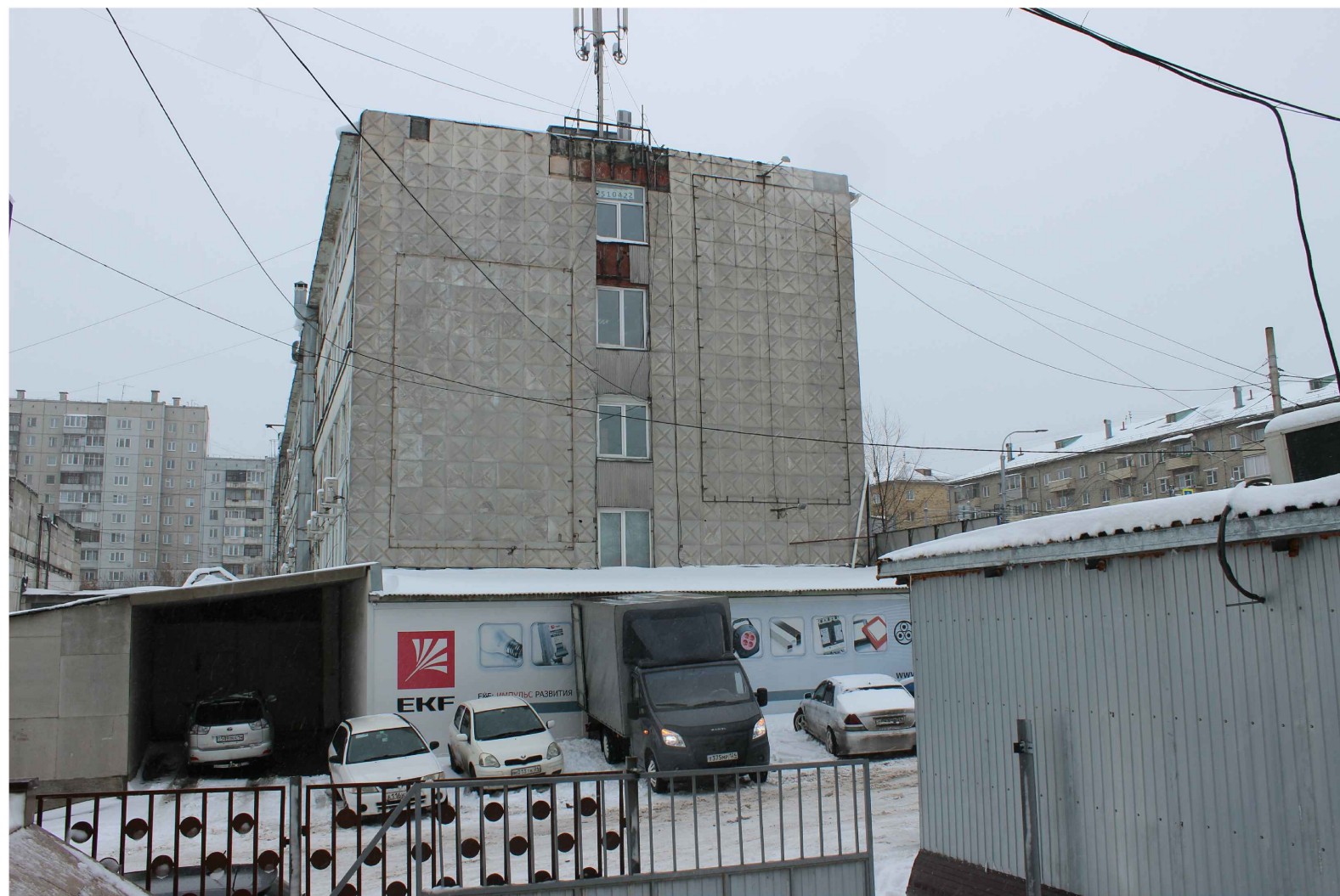
Боковой фасад (северо-западный фасад)
