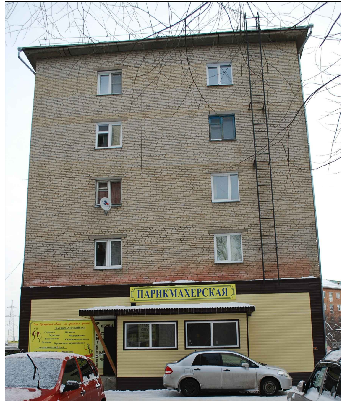
БОКОВОЙ (СЕВЕРНЫЙ) ФАСАД
