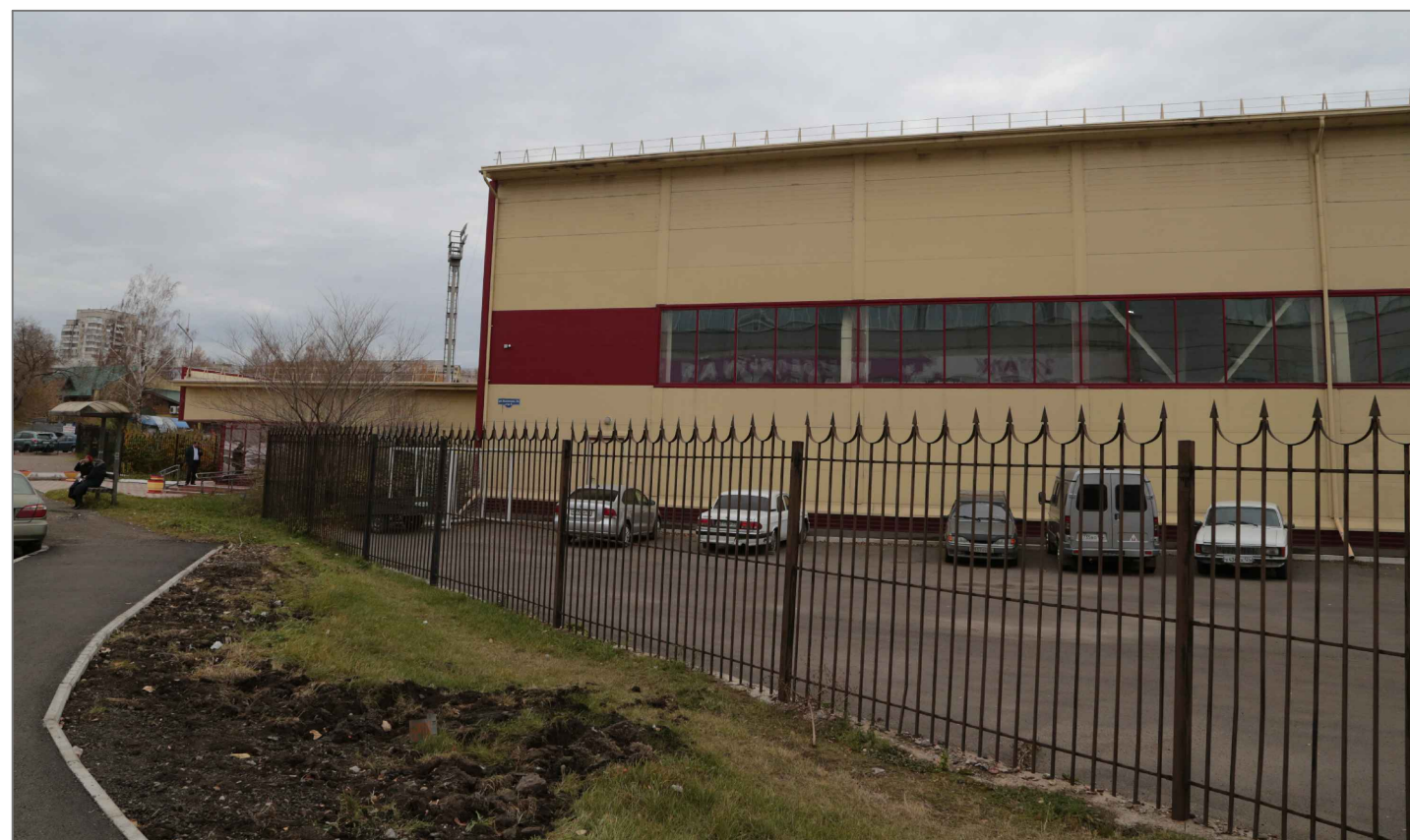
Вид 3: Фрагмент бокового фасада в осях 1-12
