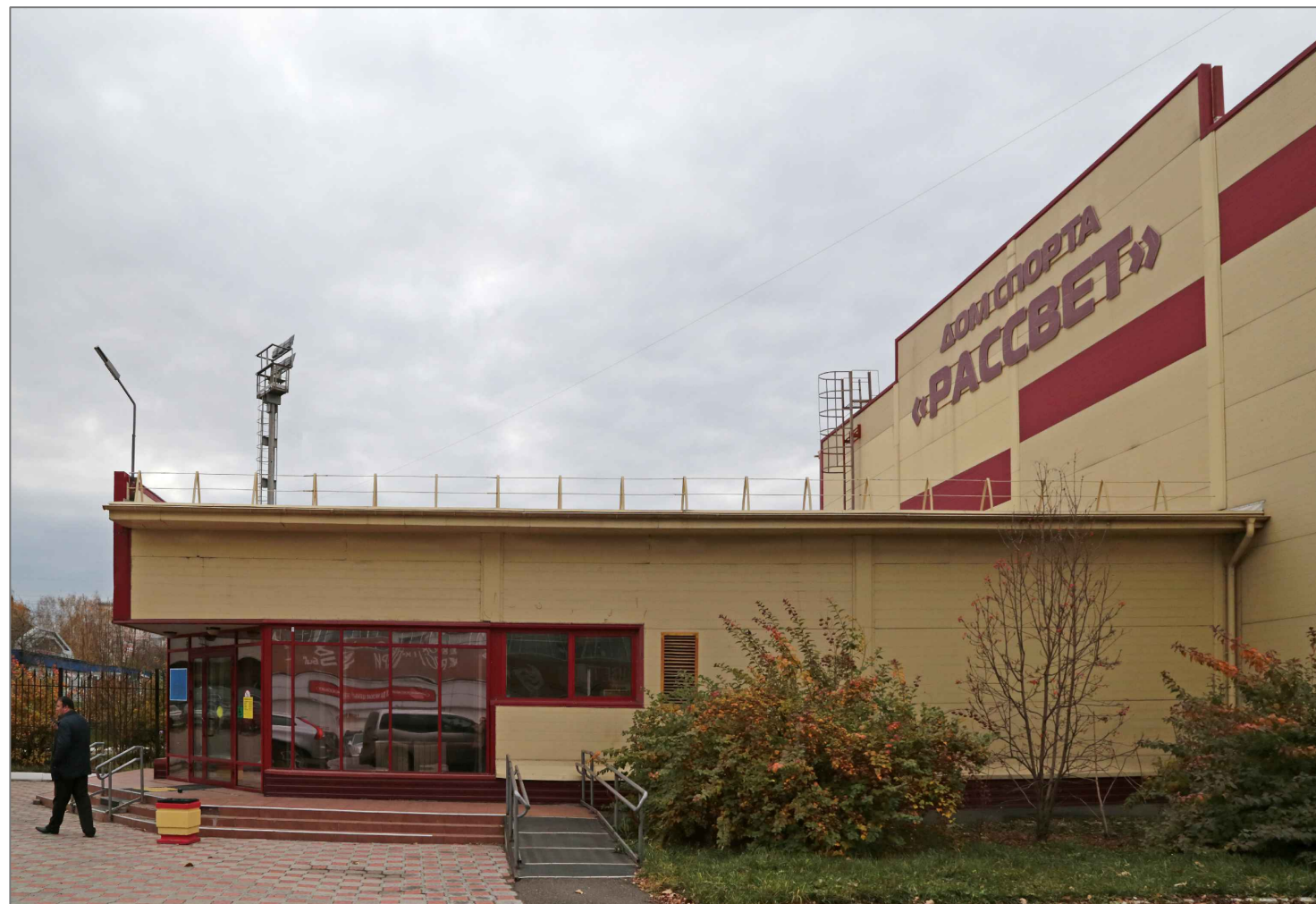
Вид 1: Фрагмент бокового фасада в осях 1-12
