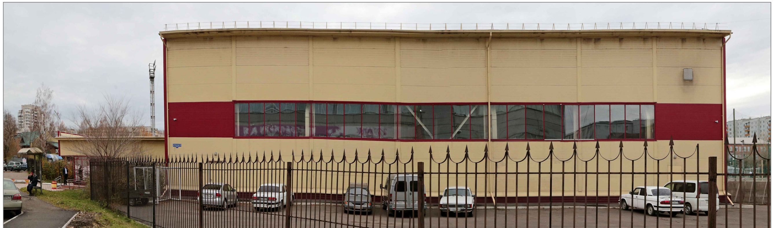
Боковой фасад в осях 1-12
