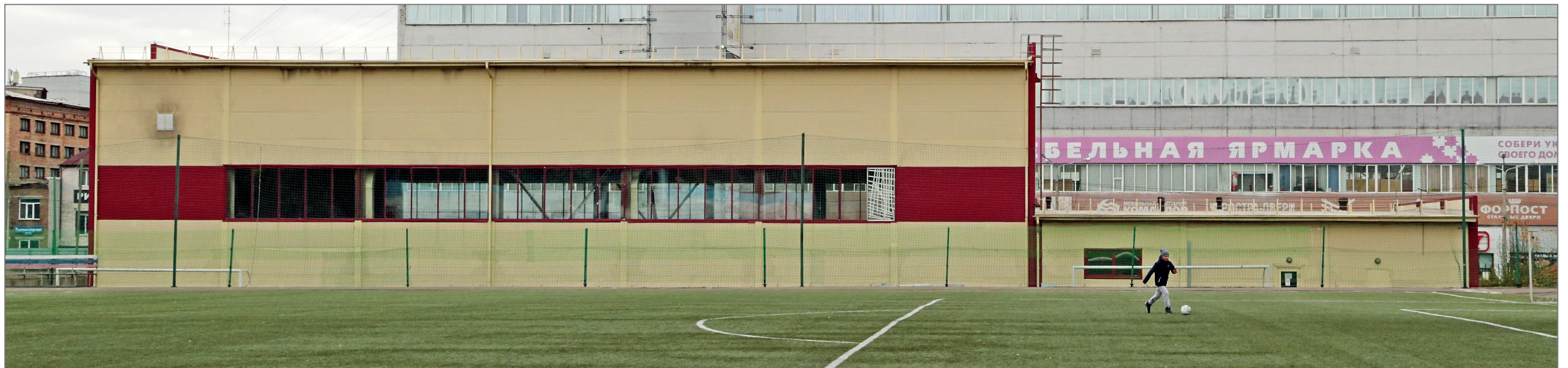
Боковой фасад в осях 12-1
