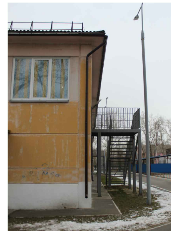
Фрагмент фасада (в осях В - А)
