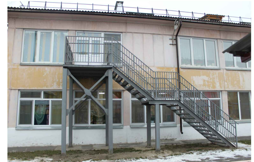
Фрагмент фасада (в осях10 - 1)
