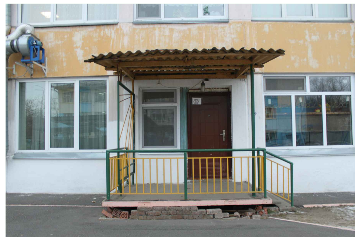
Фрагмент фасада ( в осях 1- 10)
