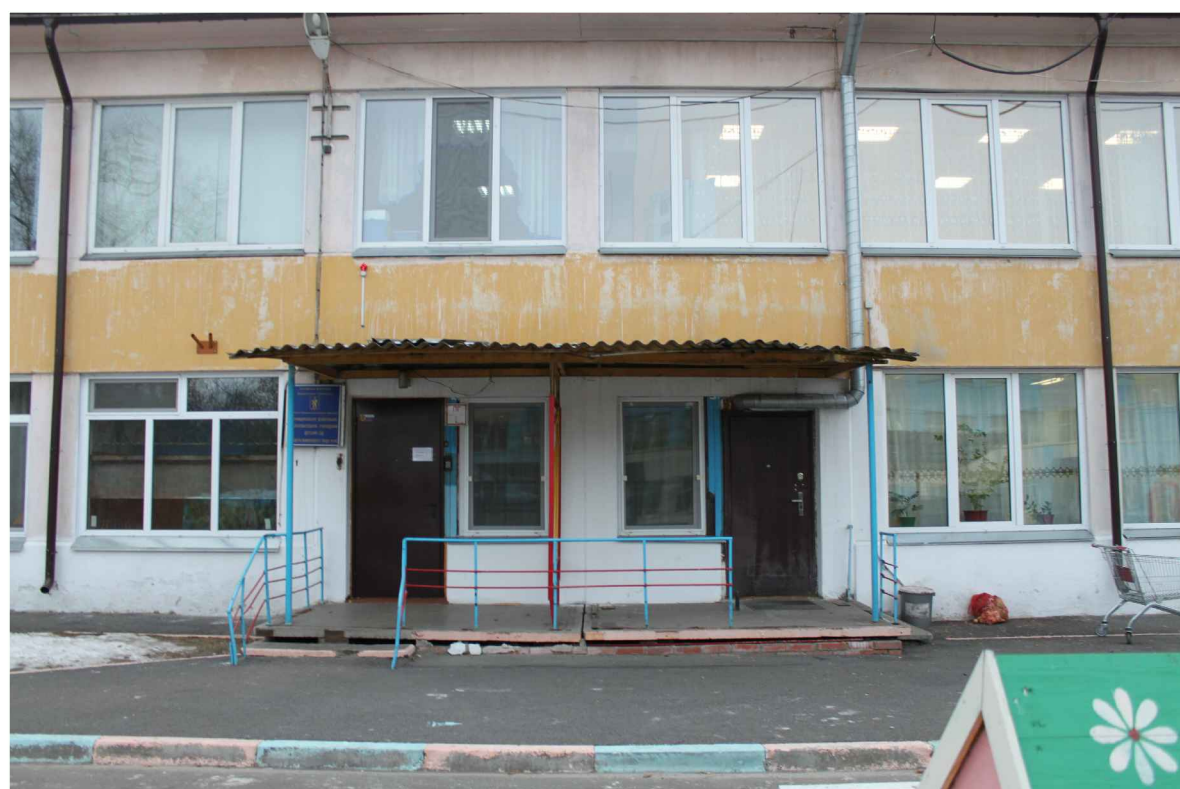
Фрагмент фасада ( в осях 1- 10)
