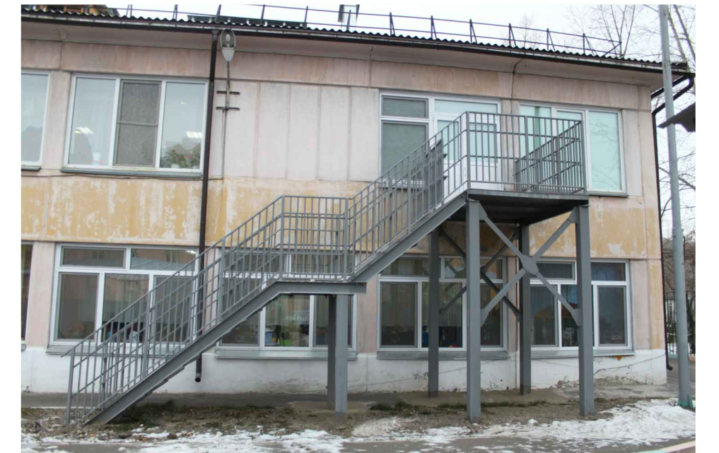
Фрагмент фасада (в осях 10 - 1)
