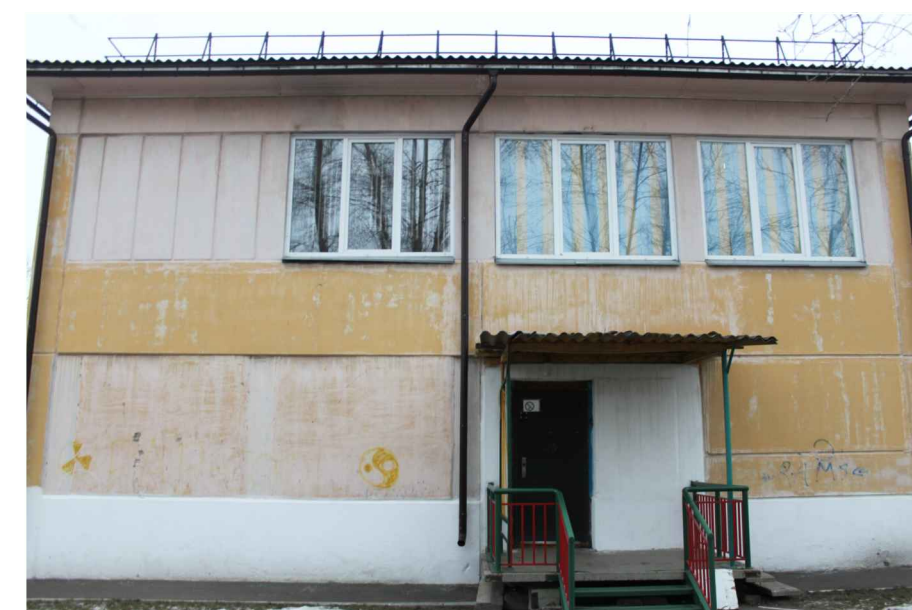
Фрагмент фасада (в осях В - А)
