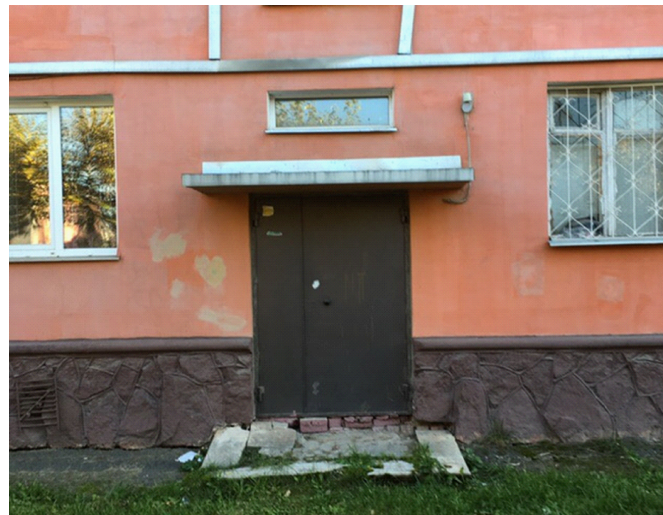
Фрагмент главного фасада
