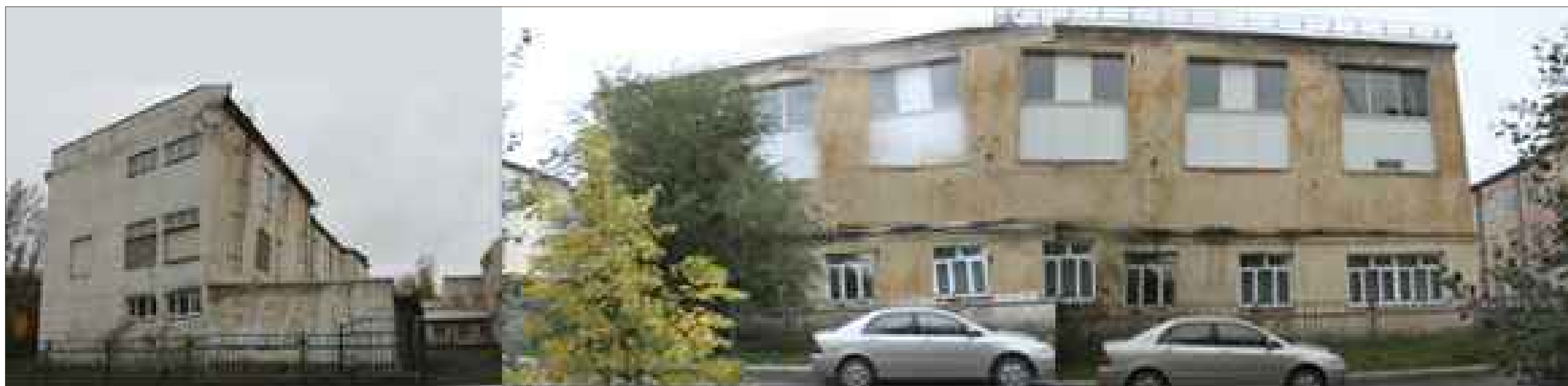
Материалы фотофиксации существующего состояния фасадов. Дворовой фасад в осях 27-1
