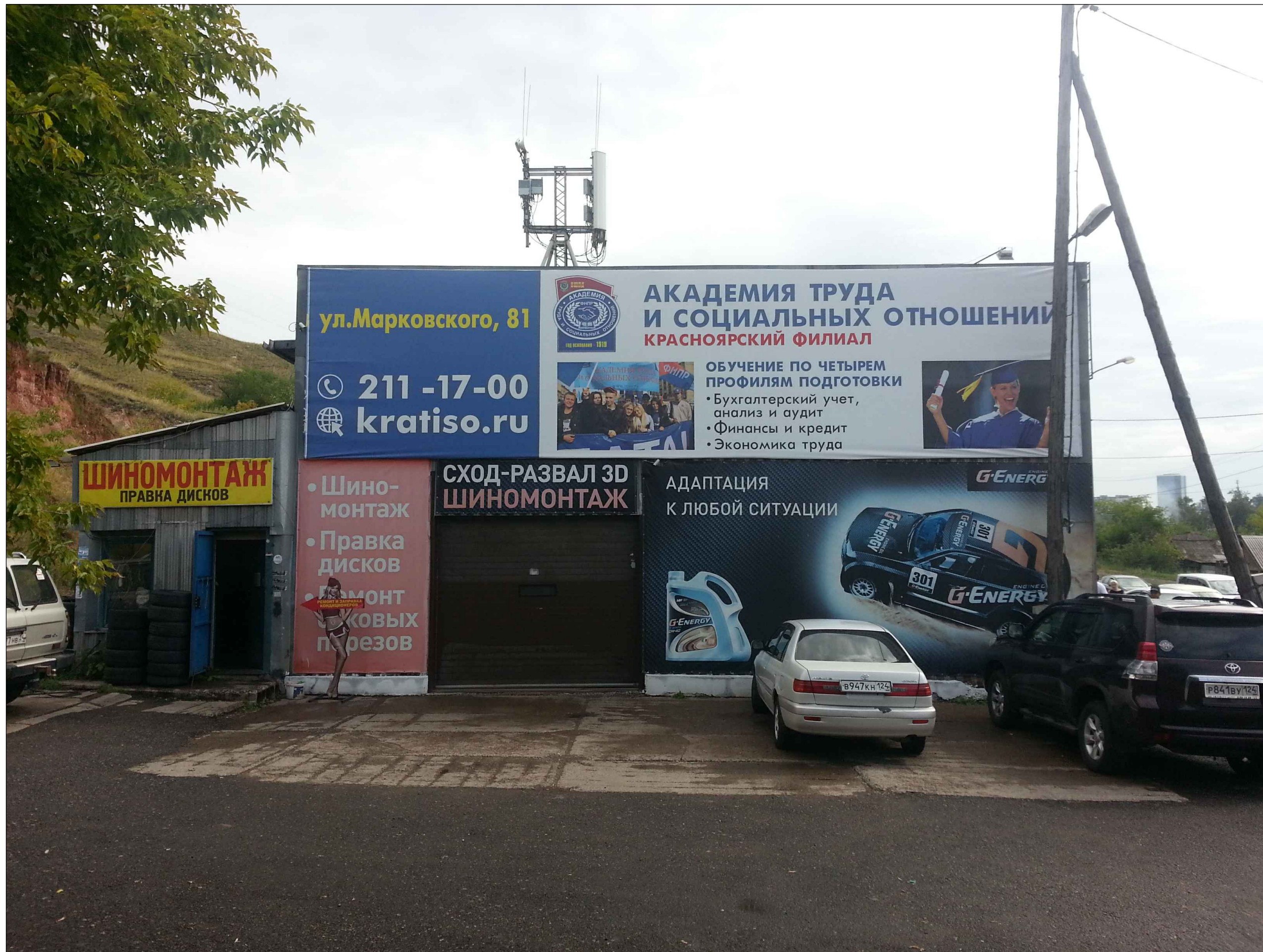
Материалы фотофиксации существующего состояния фасадов. Боковой фасад в осях Г-А
