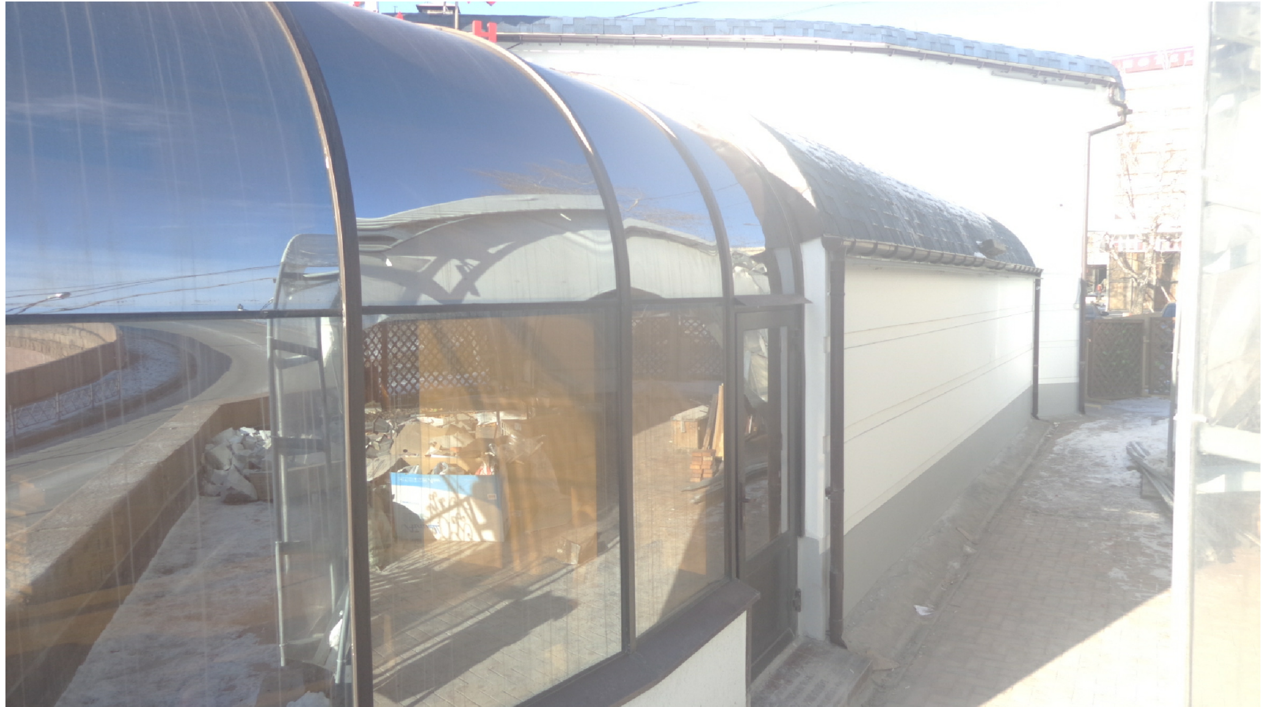
Боковой (западный) фасад
