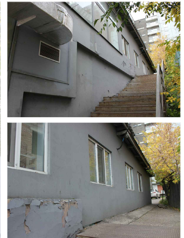
Фрагменты фасада в осях Б-Е
