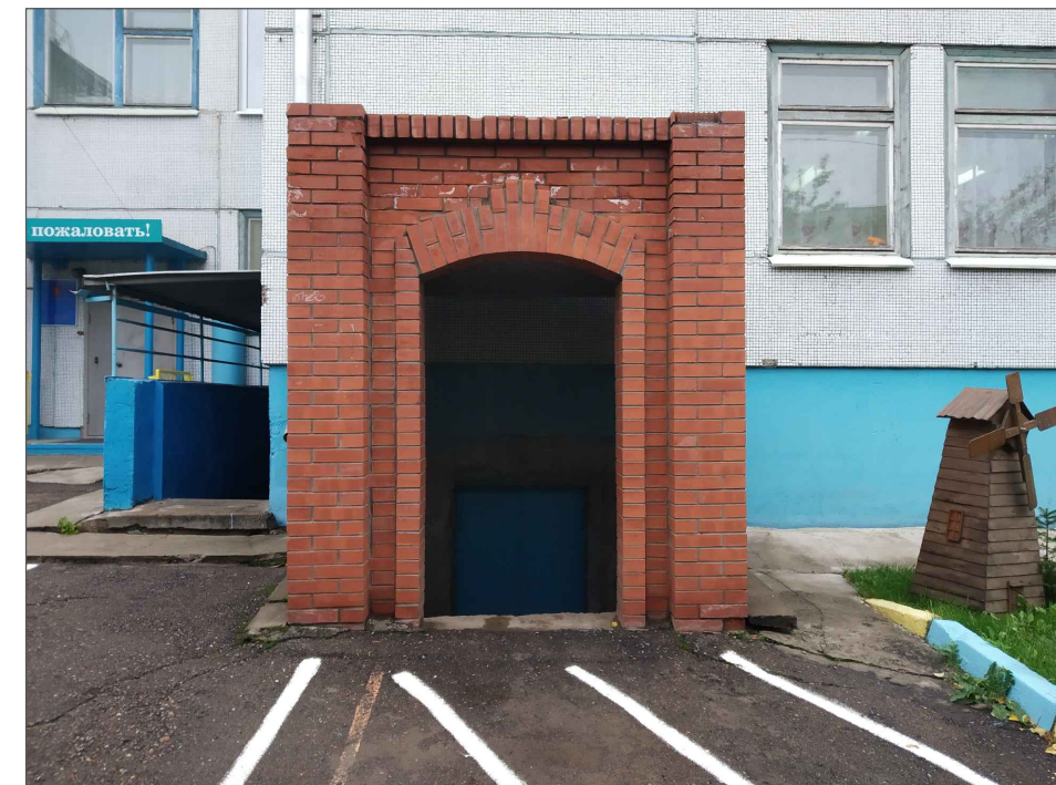
Фрагмент 4 южного фасада
