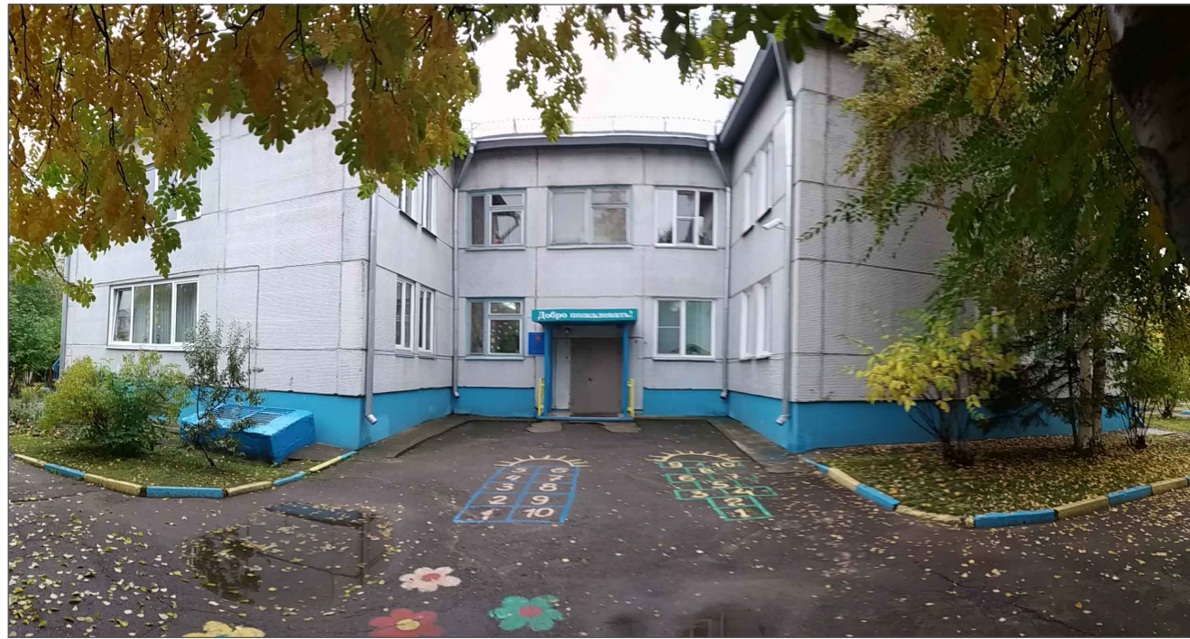
Фотофиксация северного фасада
