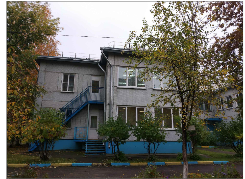
Фрагмент 1 восточного фасада
