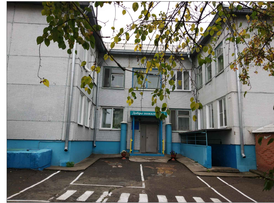
Фрагмент 2 южного фасада
