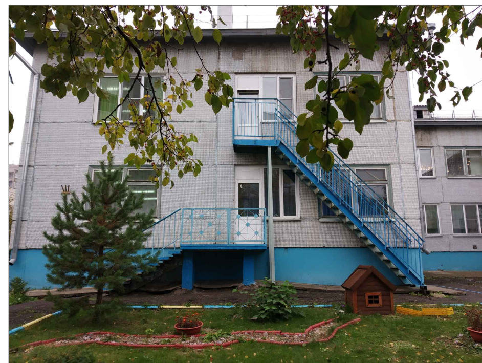
Фрагмент 1 западного фасада
