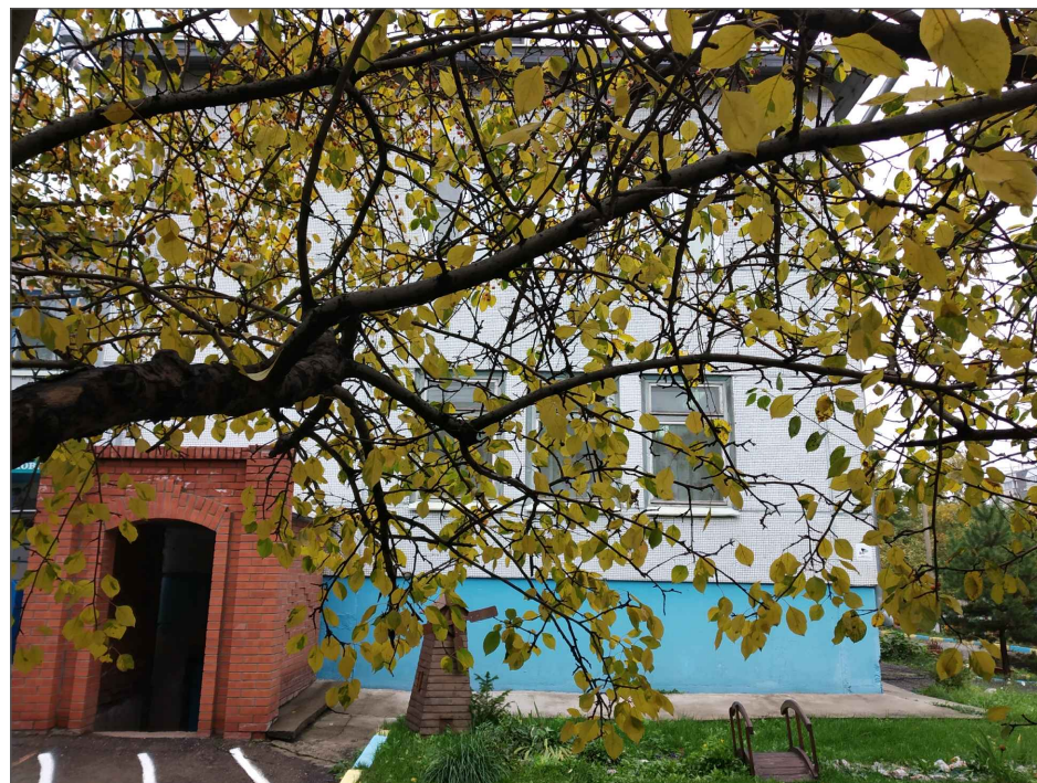
Фрагмент 3 южного фасада
