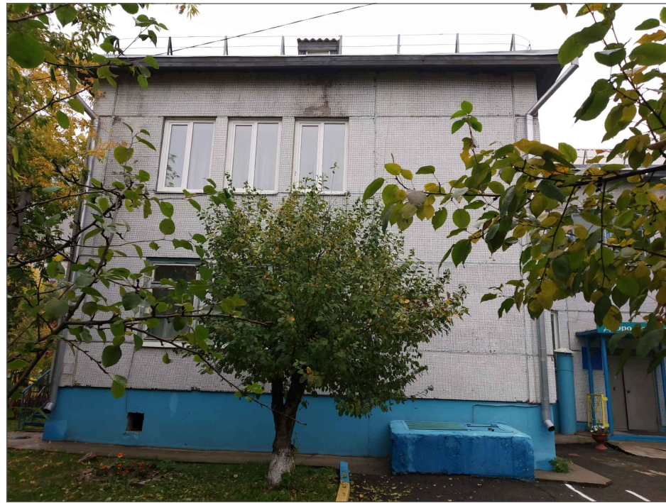
Фрагмент 1 южного фасада
