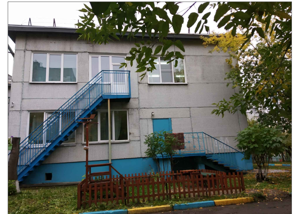
Фрагмент 3 восточного фасада
