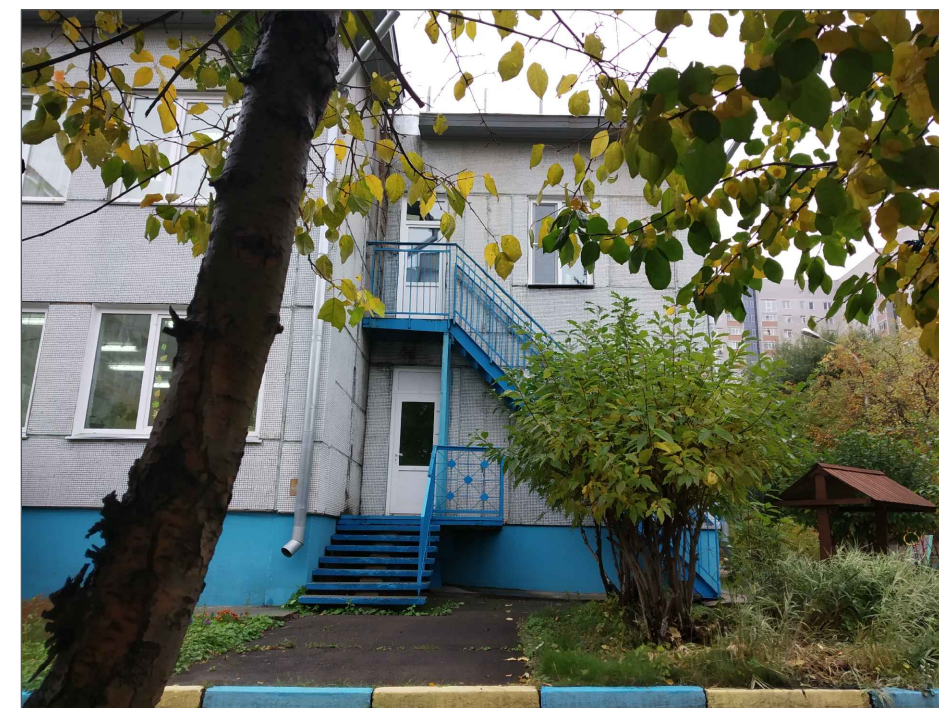
Фрагмент 4 западного фасада
