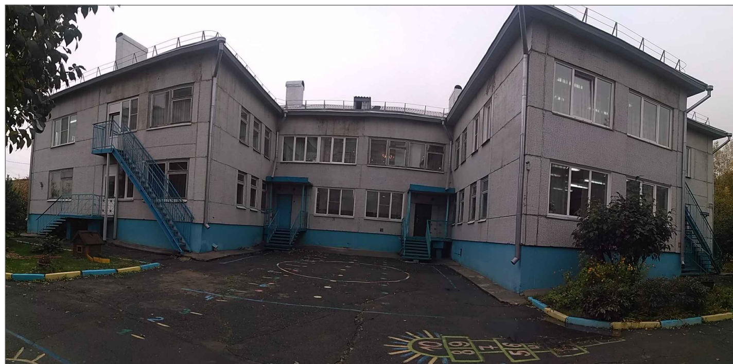
Фотофиксация западного фасада
