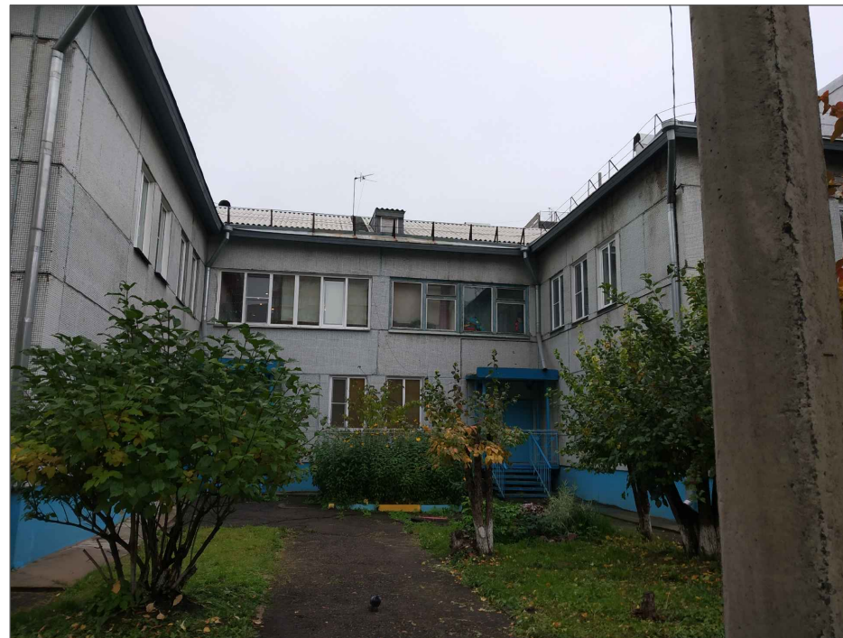
Фрагмент 2 восточного фасада
