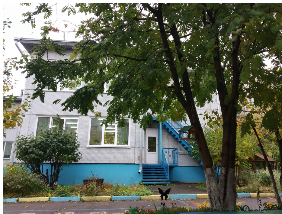
Фрагмент 3 западного фасада
