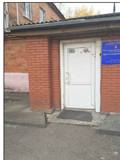
рис. 5 Фрагмент южного фасада (переход между корпусами 1 и 2, пристроенный тамбур с западной стороны).
