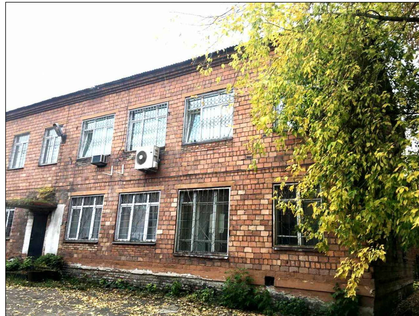
рис. 8 Восточный фасад (вид с северо-восточного угла здания)
