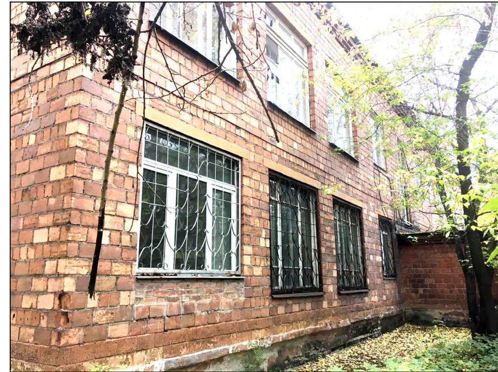
рис. 14 Фрагмент западного фасада (севернее перехода между корпусами 2 и 3)
