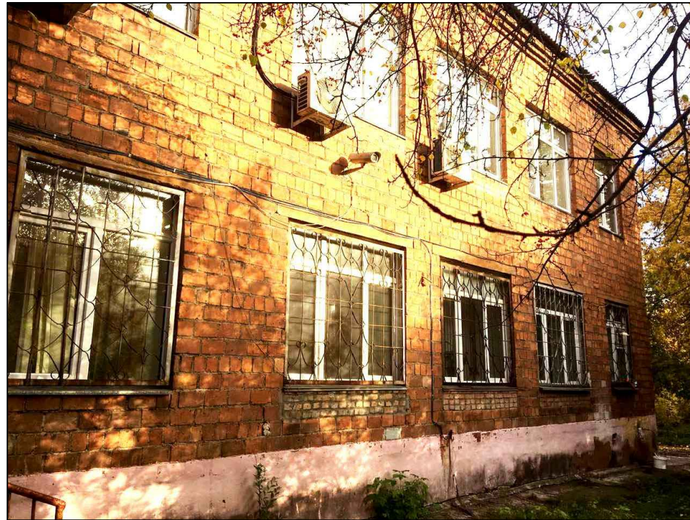
рис. 13 Фрагмент западного фасада (южнее перехода между корпусами 2 и 3)
