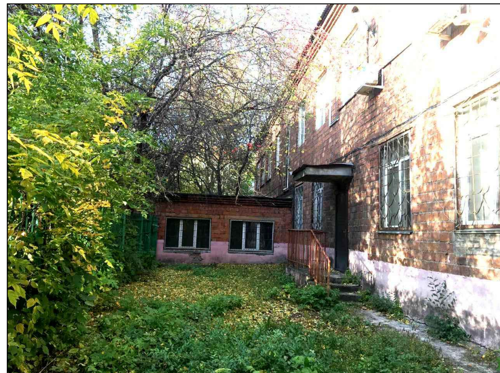
рис. 15 Фрагмент западного фасада (южнее перехода между корпусами 2 и 3)
