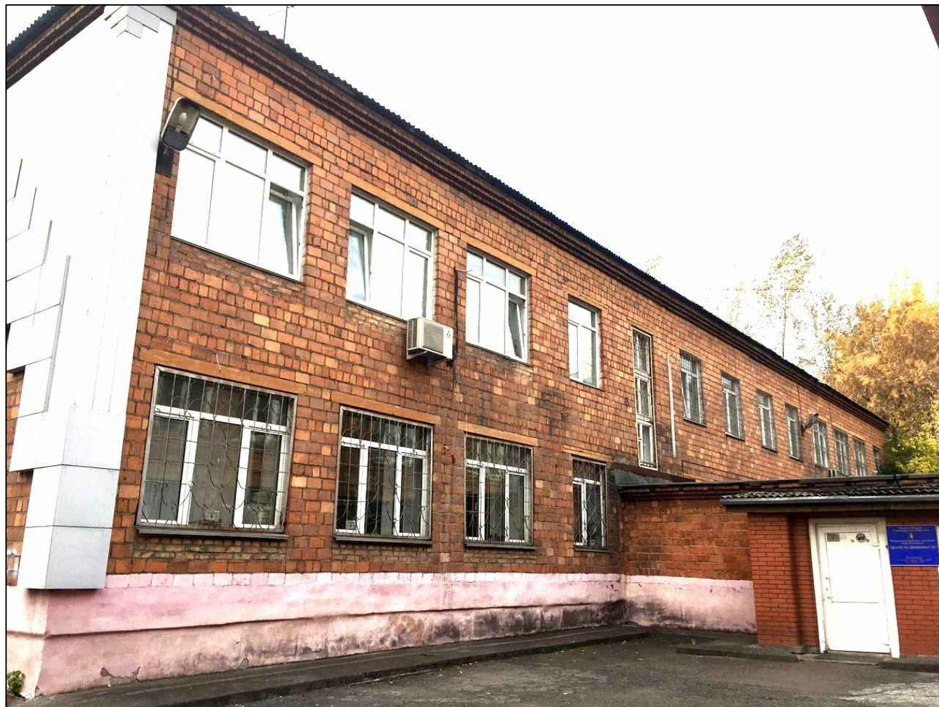
рис. 7 Восточный фасад (вид с юго-восточного угла здания)
