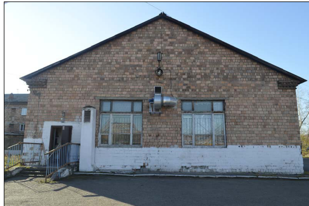
Фотофиксация существующего состояния фасадов Фрагмент фасада в осях М-Р
