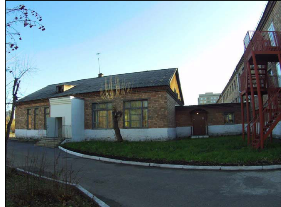
Фотофиксация существующего состояния фасадов Фрагмент фасада в осях 5-3
