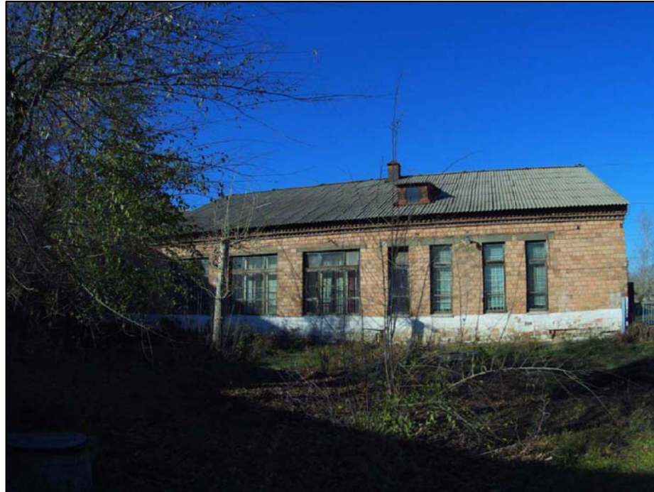
Фотофиксация существующего состояния фасадов Фрагмент фасада в осях 4-5
