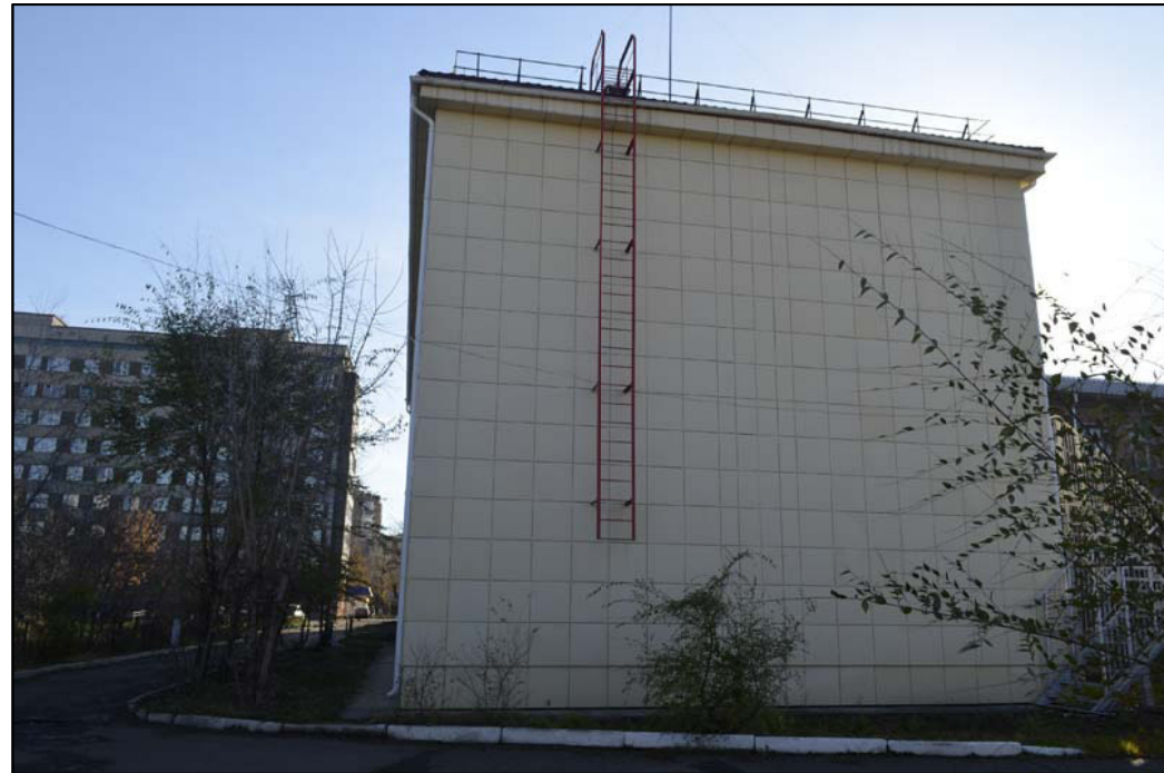
Фотофиксация существующего состояния фасадов Фрагмент фасада в осях 16-14
