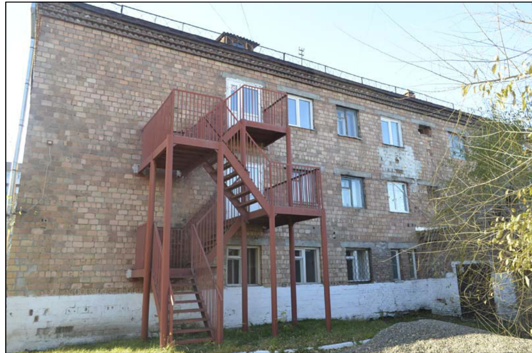
Фотофиксация существующего состояния фасадов Фрагмент фасада в осях Е-Ж
