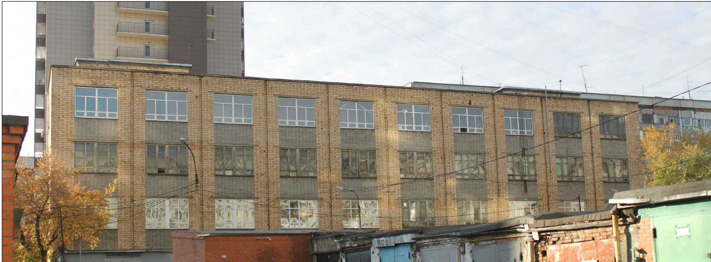
Материалы фотофиксации существующего состояния фасадов. Дворовой фасад в осях Б-А
