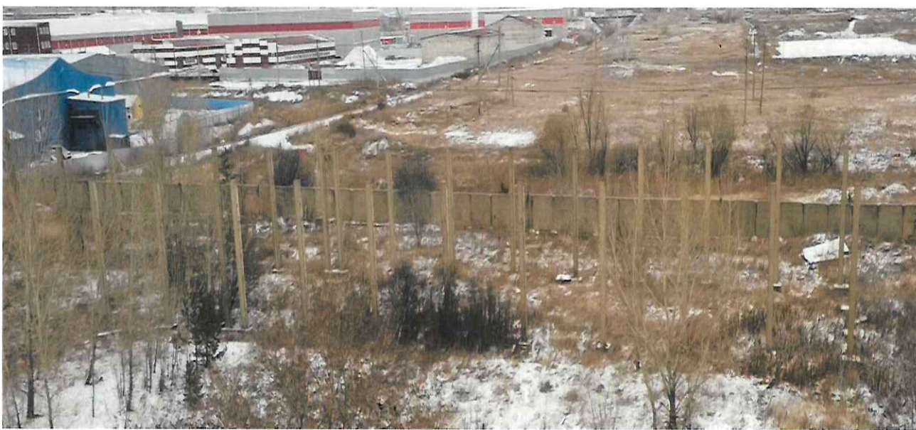
объект незавершенного строительства (объект 2)
