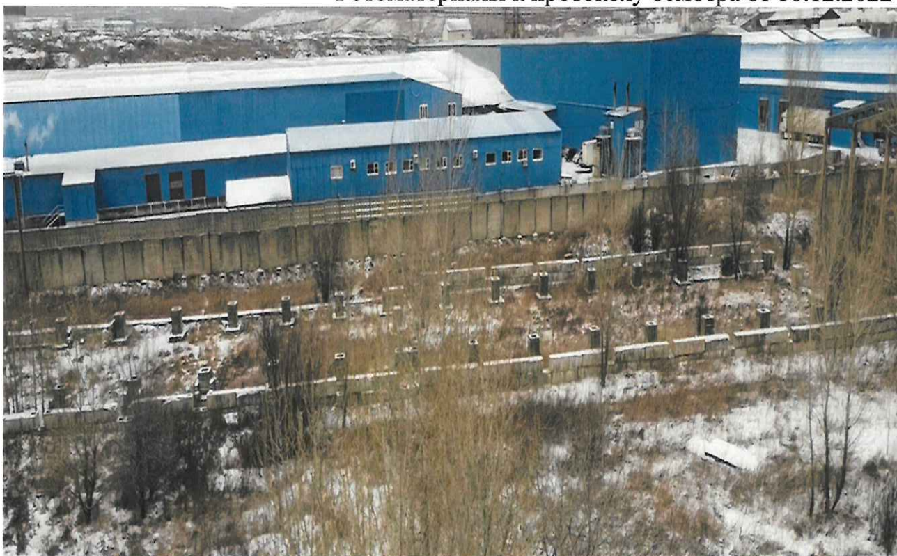
объект незавершенного строительства (объект 1)
