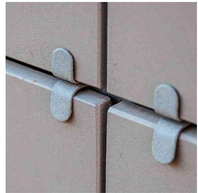
✗ ОТКРЫТАЯ СИСТЕМА КРЕПЛЕНИЯ ВЕНТИЛИРУЕМОГО ФАСАДА
