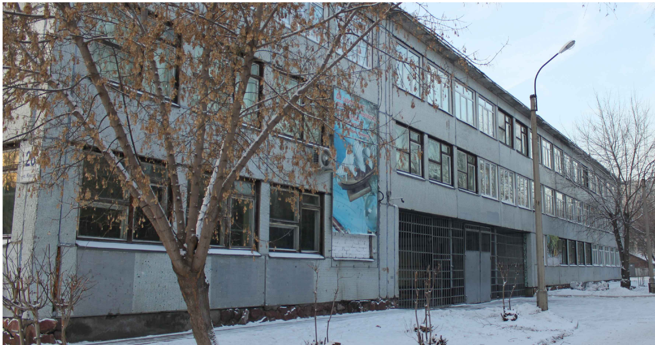
Материалы фотофиксации существующего состояния фасадов. Дворовой фасад.
