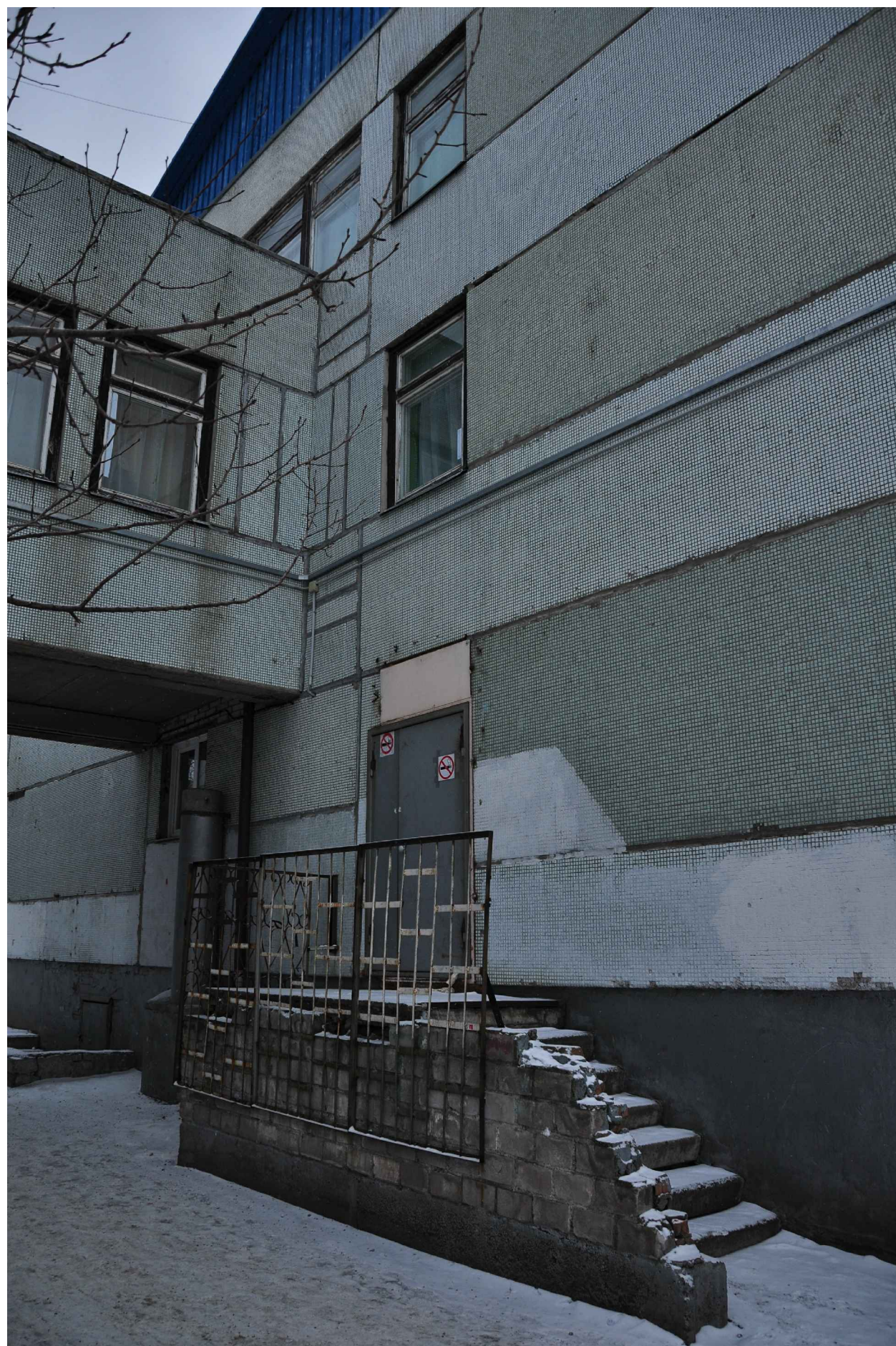
Материалы фотофиксации существующего состояния фасадов. Боковой фасад в осях А'-Д'.
