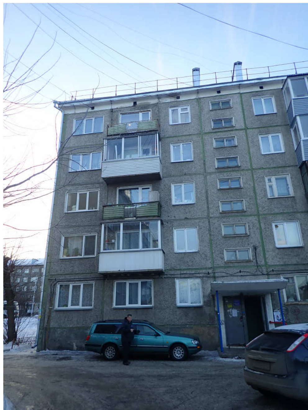
Фрагмент фасада в осях 1-2
