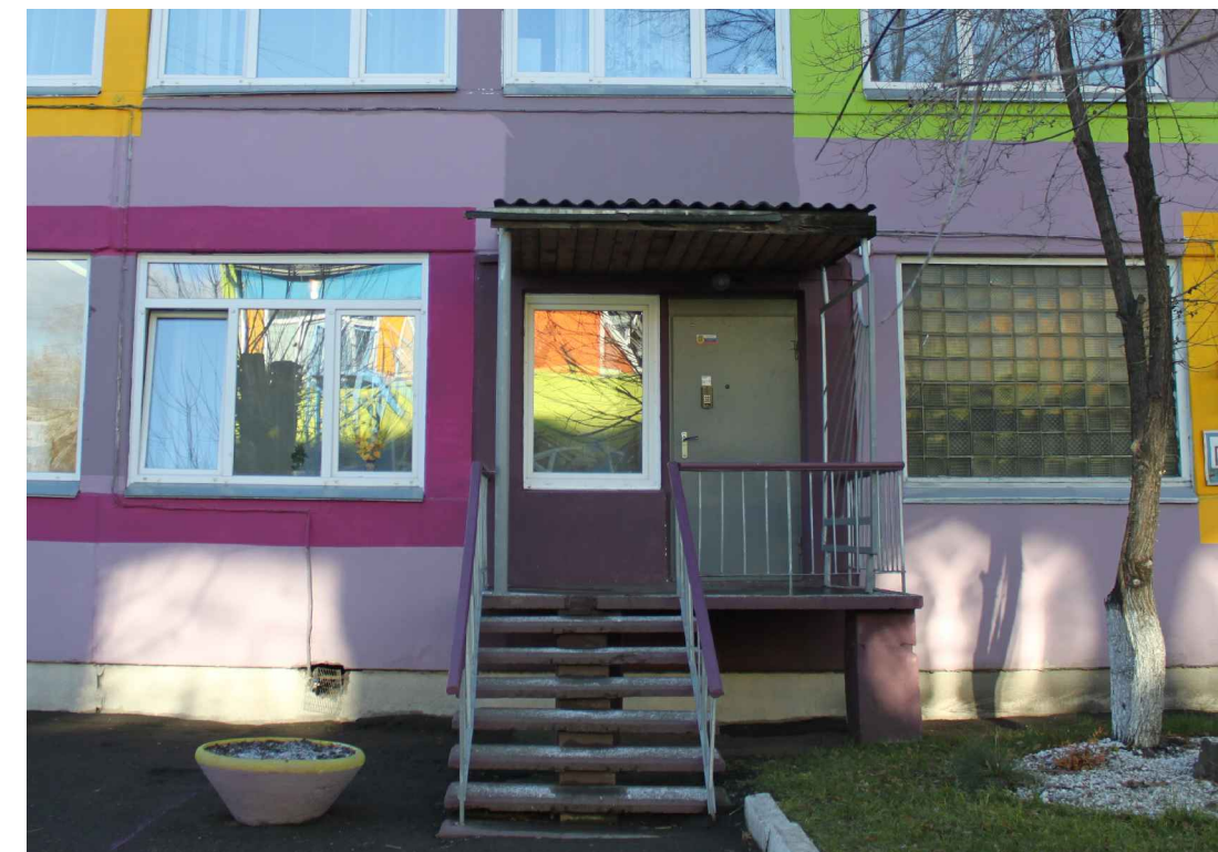
Фрагмент фасада ( в осях 1- 10)
