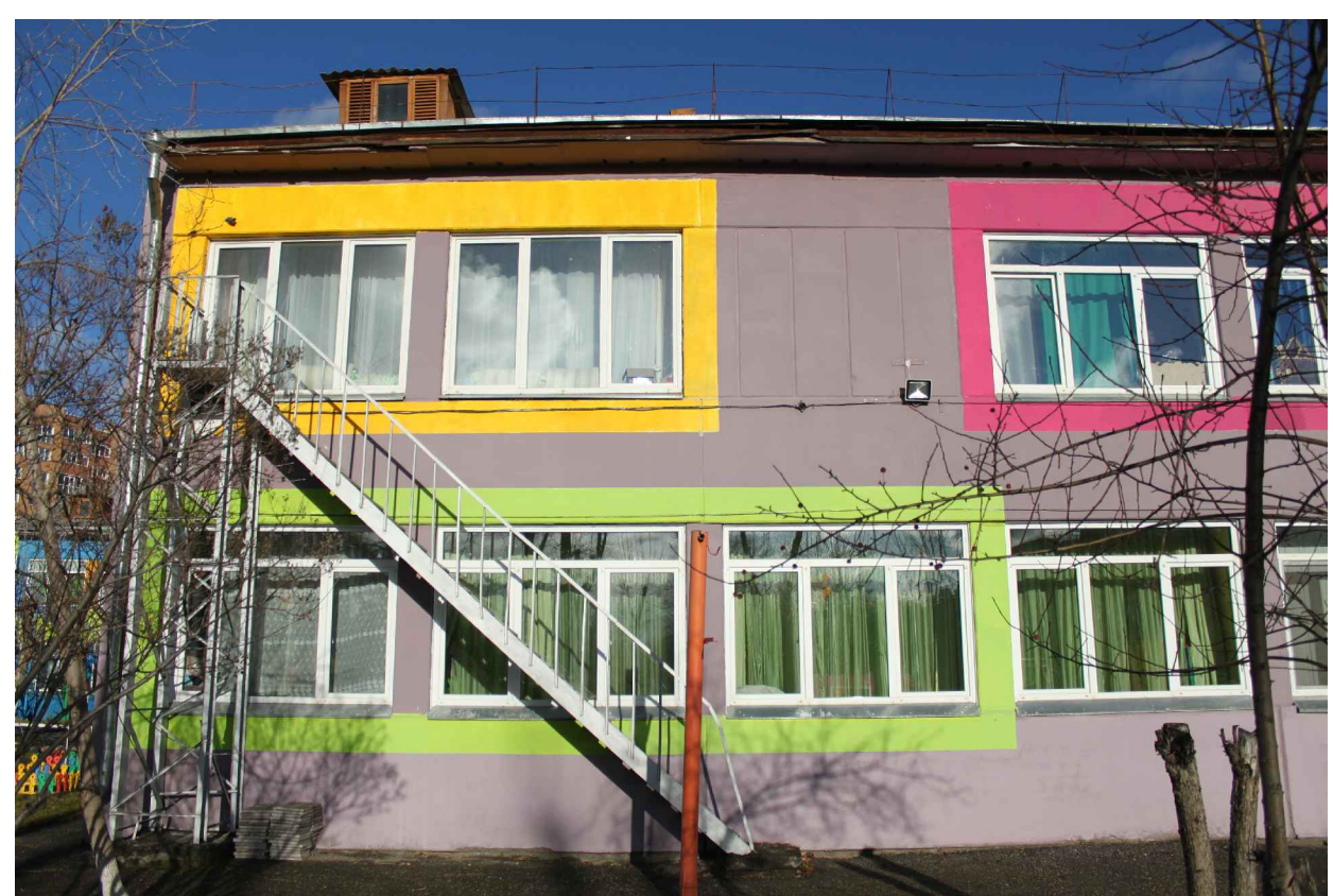
Фрагмент фасада (в осях10 - 1)
