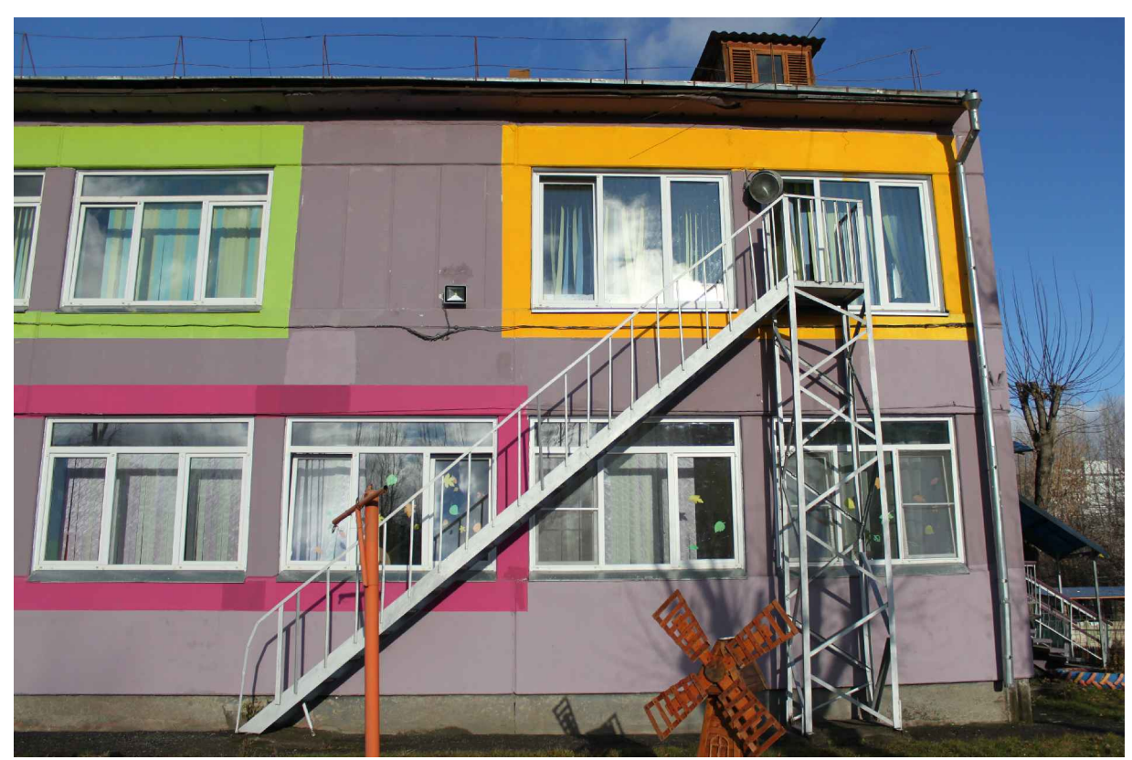
Фрагмент фасада (в осях10 - 1)
