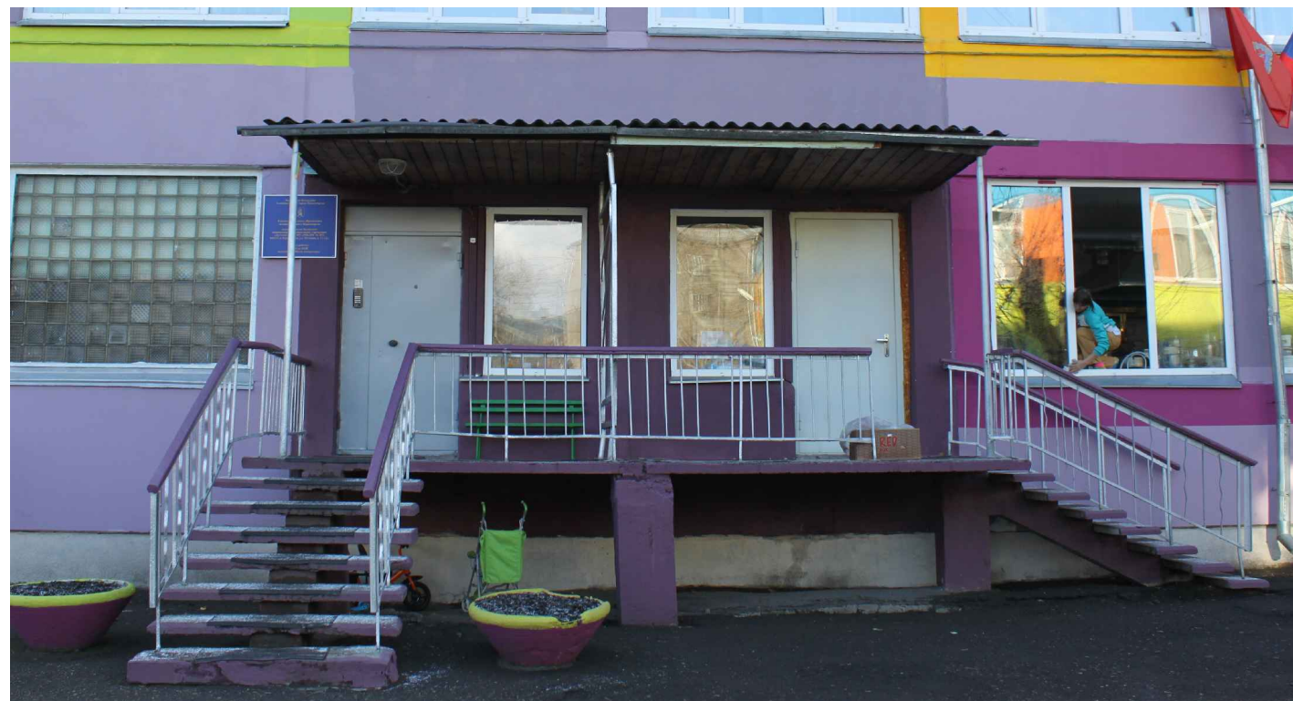
Фрагмент фасада ( в осях 1- 10)
