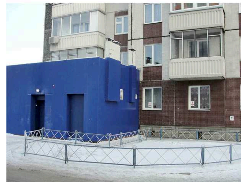
Фрагмент фасада в осях 3-1
