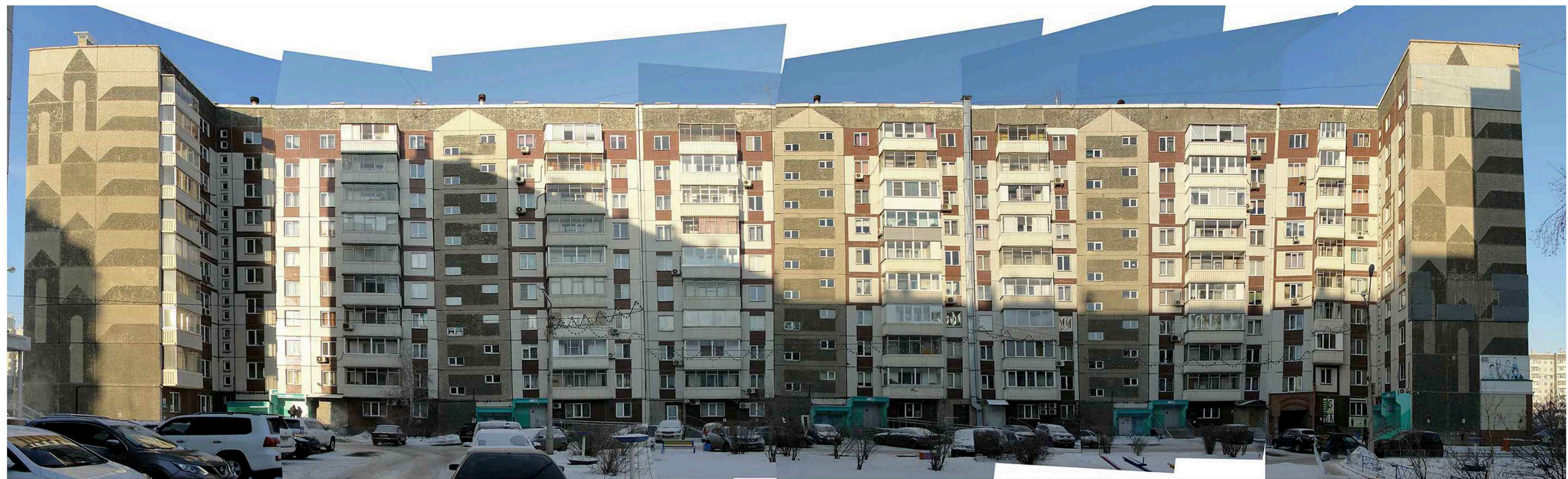
Дворовой фасад в осях Б-А
