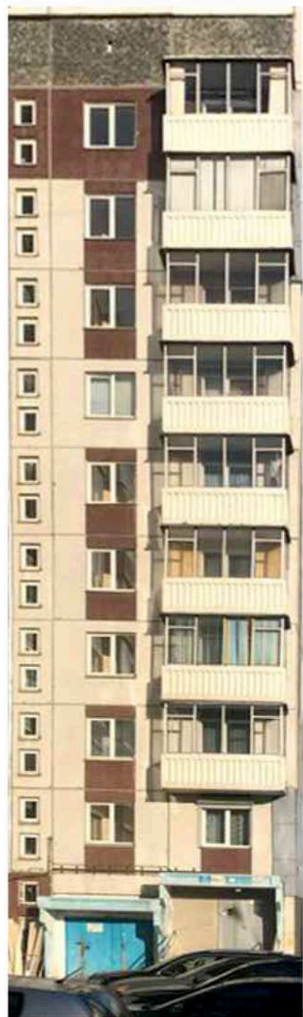
Дворовой фасад в осях 2-1
