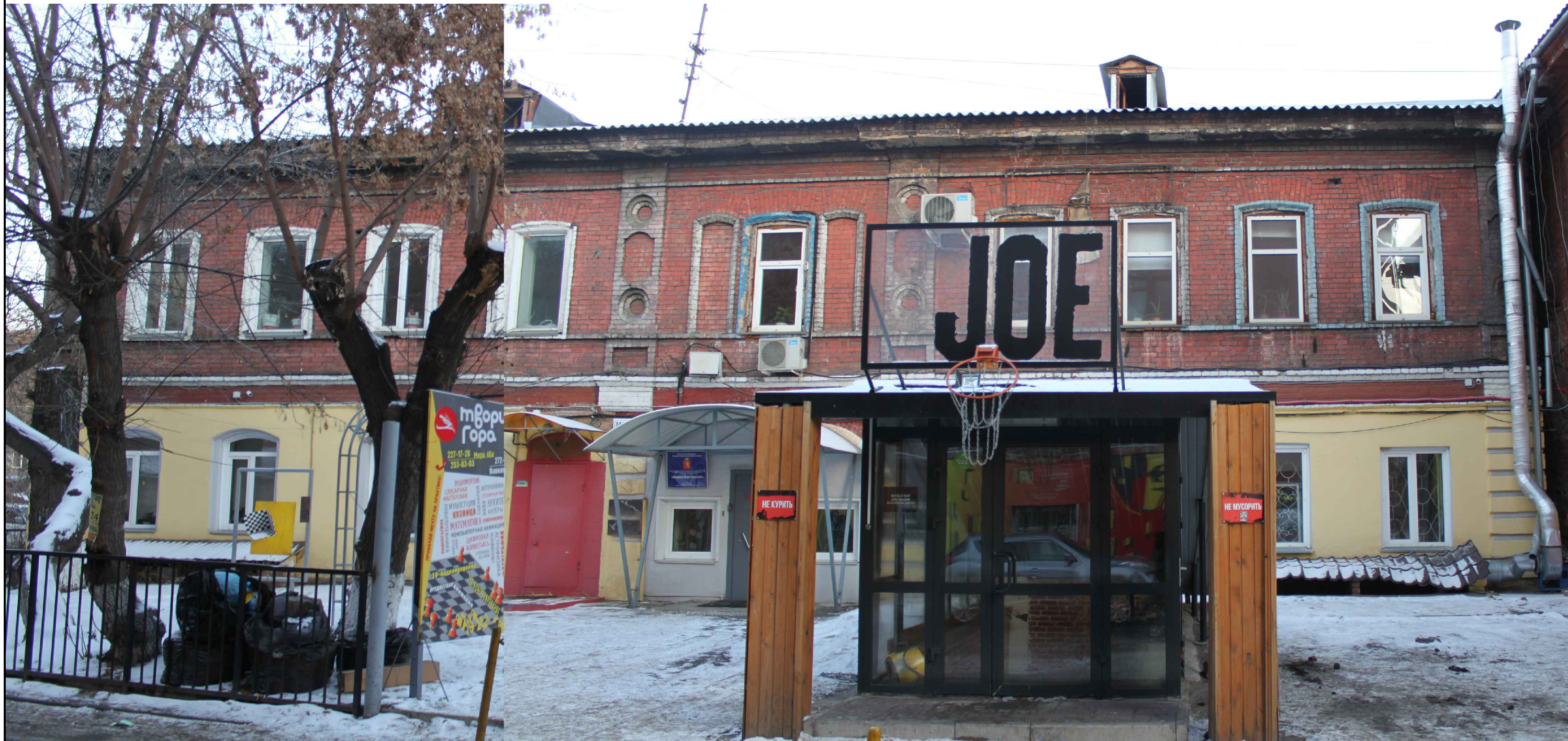
Материалы фотофиксации существующего состояния фасадов. Главный фасад в осях 1-6
