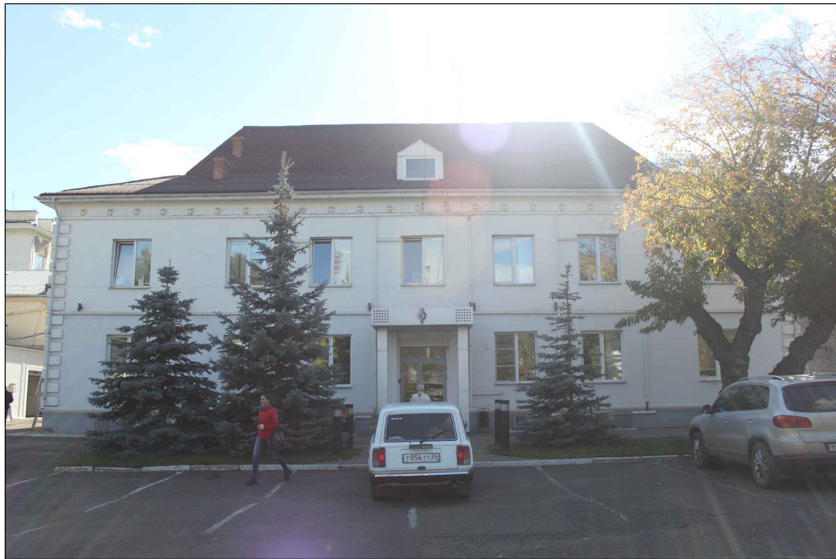
Материалы фотофиксации существующего состояния фасадов. Главный фасад в осях 1-6
