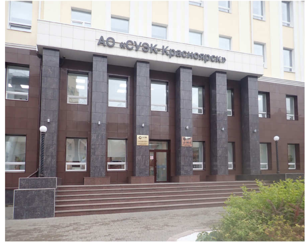
Фрагмент фасада в осях 5-1
