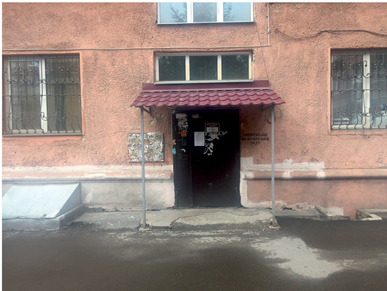
Фрагмент фасада В
