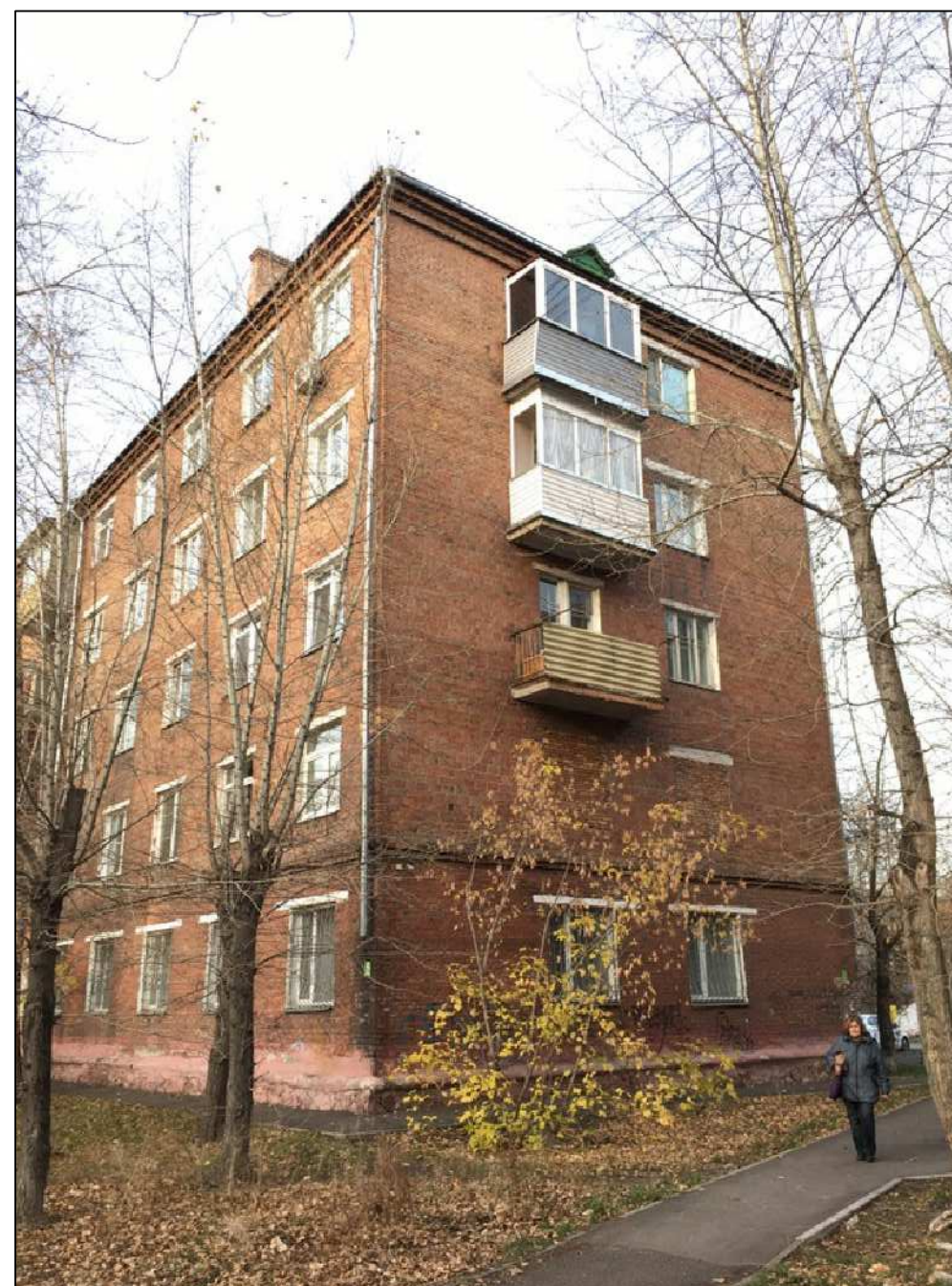
Боковой фасад с южной стороны
