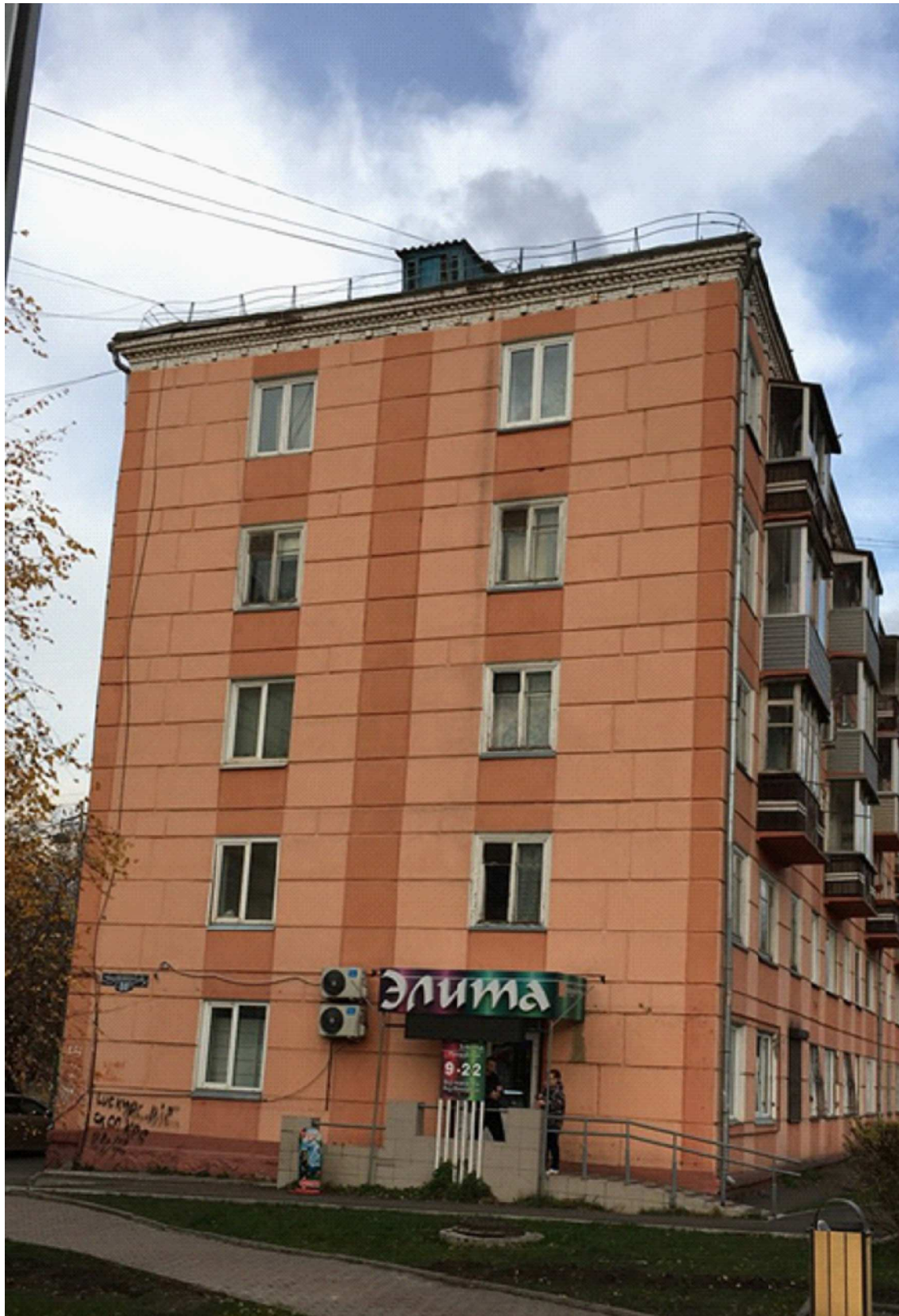
Боковой фасад по пр. Красноярский рабочий
